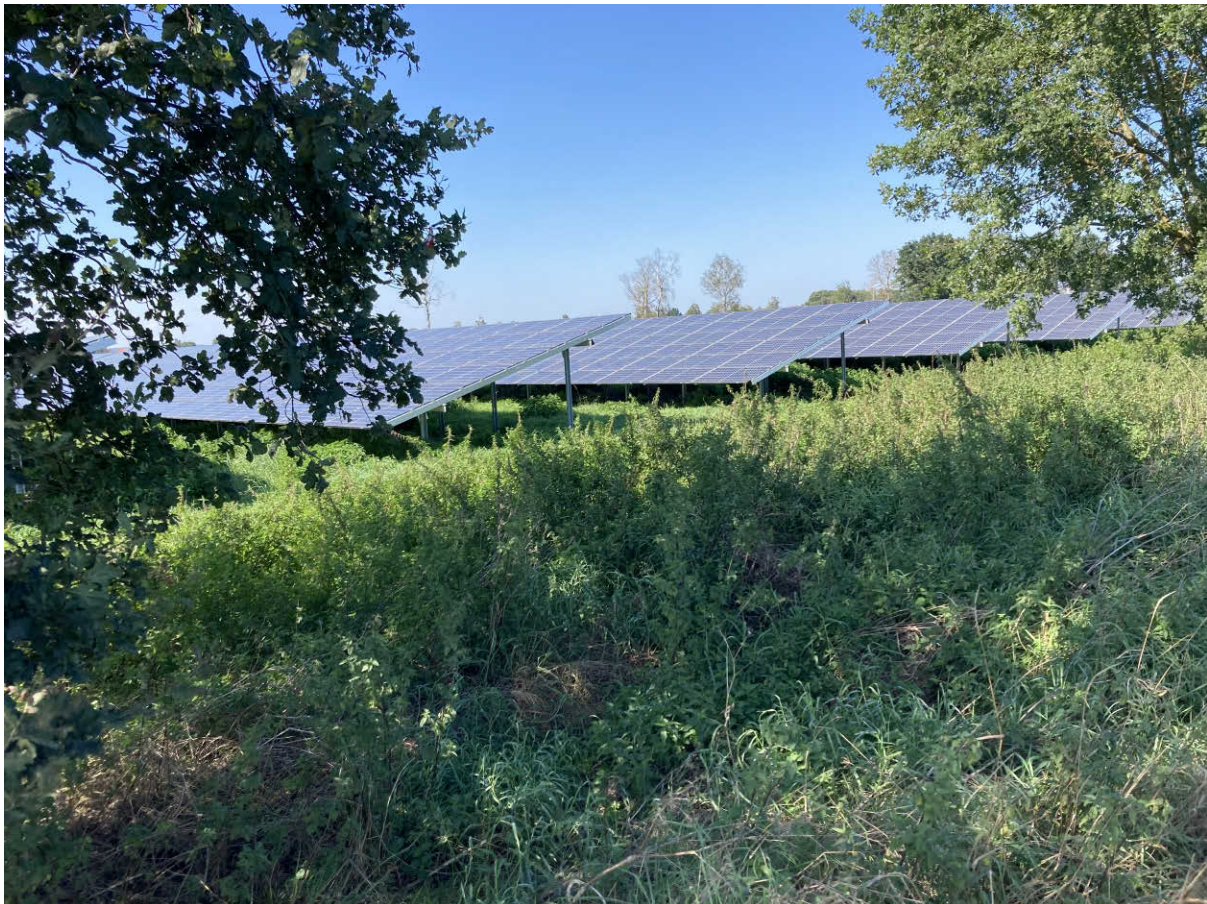
Abb. 2: PVA Schornhof, Teilfläche Nord. Zustand September 2023, nitrophile Ruderalflur, dominiert von Großer Brennessel ( Urtica dioica ) unter und zwischen den Photovoltaikpanelen. Entlang des Weges einzelne Eichen ( Quercus robur ).
