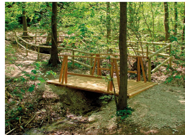
Abb. 32 und 33: Die Verrohrung an einem Quellbach wurde entfernt und durch eine Brücke ersetzt.
