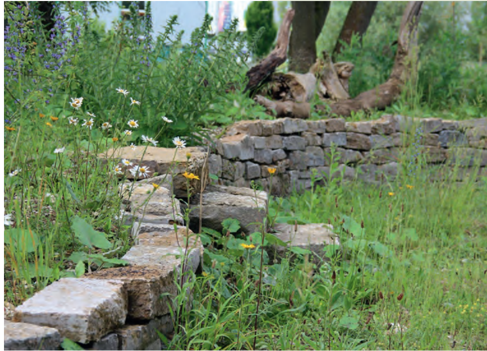
Abb. 58: Trockenmauern heißen so, weil sie ohne Mörtel aus Natursteinen aufgerichtet werden. Weil das Regenwasser durch die Hohlräume abfließt, bleiben sie tatsächlich trocken und bilden begehrte Quartiere für große und kleine Tiere.
