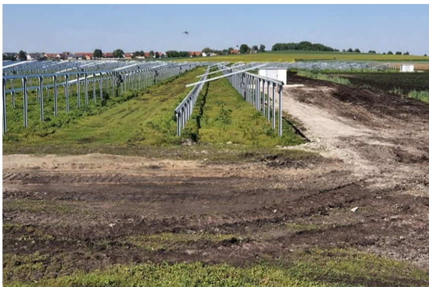
Abb. 38: 1.6.21, Nordrand des Süd- teils, Blick nach Westen Module erst teilweise mon- tiert
