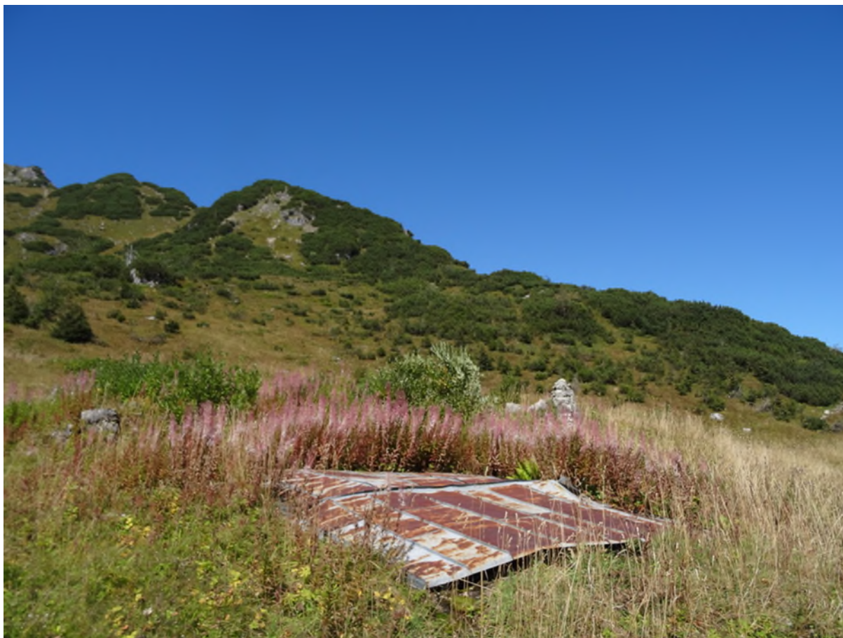
Abb. 5: Untersuchungsfläche Roßgundalpe, Blick auf das verfallene Wirtschaftsgebäude
