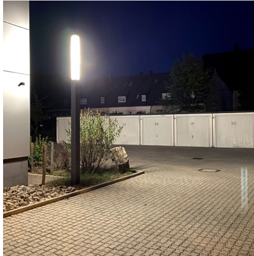
Abb. 26a, links und 26b, rechts: Nicht abgeschirmte Lampen sind Negativbeispiele nächtlicher Beleuchtung: Sie geben Licht in alle Richtungen ab, blenden bei hoher Lichtintensität Passanten und beleuchten Bäume, Gehölze und den Nachthimmel in unnötiger Weise.
