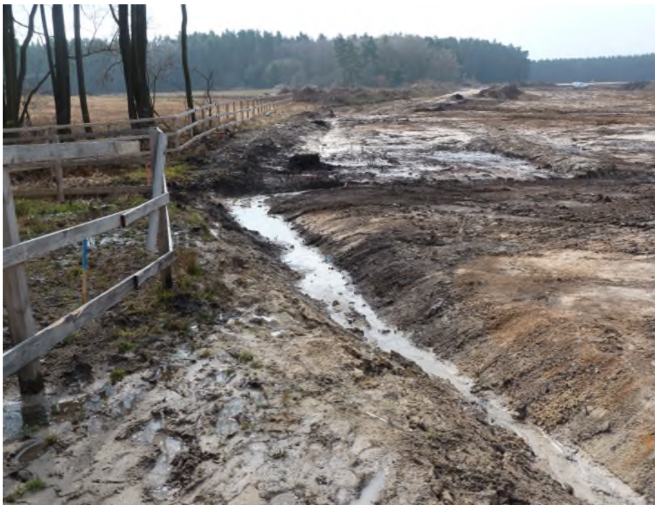
Abb. 20: Baufeld im Bereich der Wernsbach-Querung (Foto: Staatliches Bau- amt Nürnberg)
