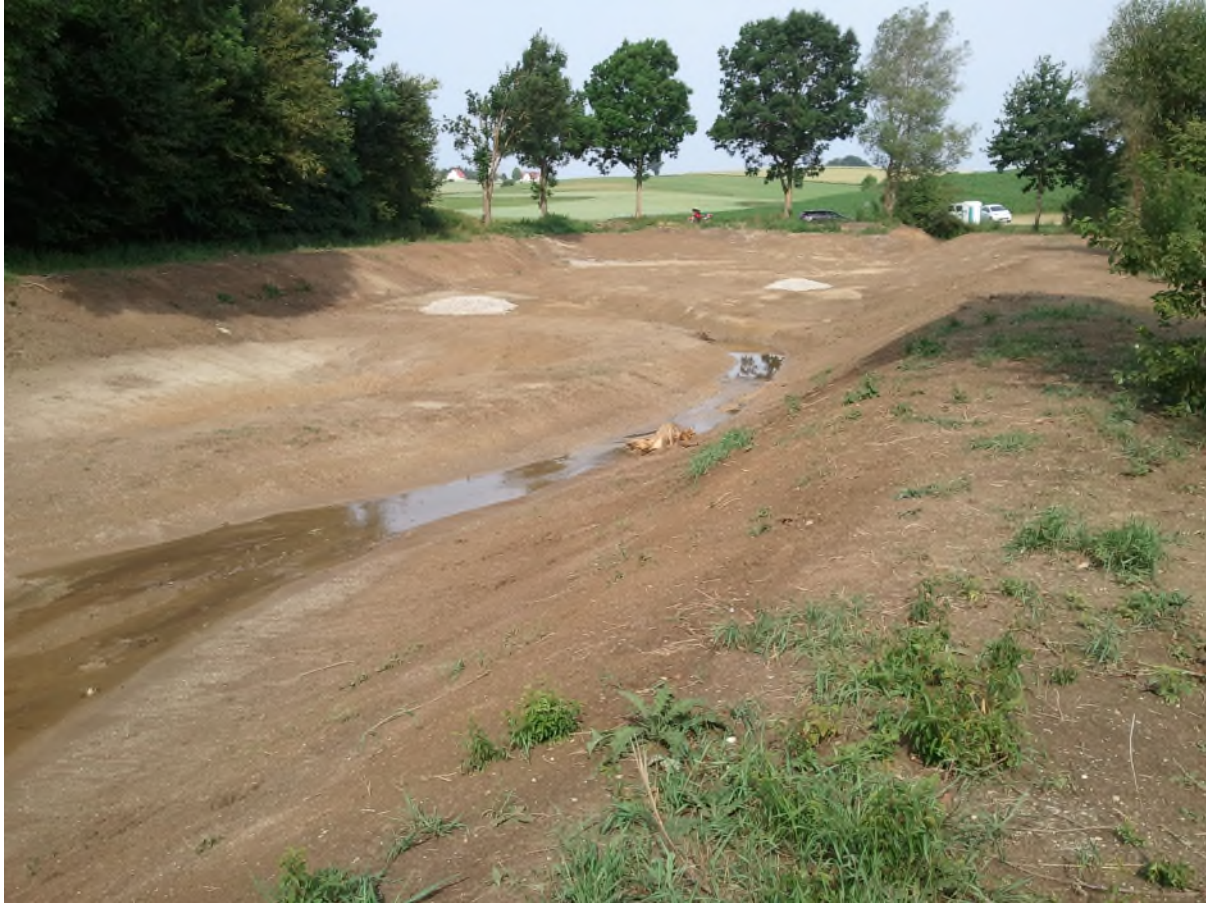
Abb. 32: Das Foto aus dem Gutachten zur Bauabnahme vom 24.06.2017 durch den wasserrechtlichen Sachverständigen vermittelt einen Eindruck der Fläche zum Zeitpunkt der Bauabnahme: Gewässerlauf mit Totholz und Kieshaufen. (Foto: Konrad Kuffer)
