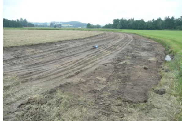
Abb. 44: Böschungsabflachung am Graben (Foto: Brigitte Fischer, Landratsamt Unterallgäu, untere Naturschutzbehörde)
