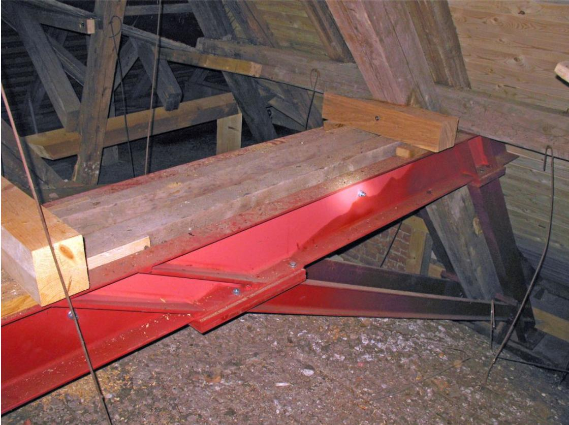
Abb. 43: Kath. Kirche Medlitz: Im Herbst 2014 wurden im Langhausdachstuhl zwei Stahlträger eingebaut (Foto vom 11.07.2015)
