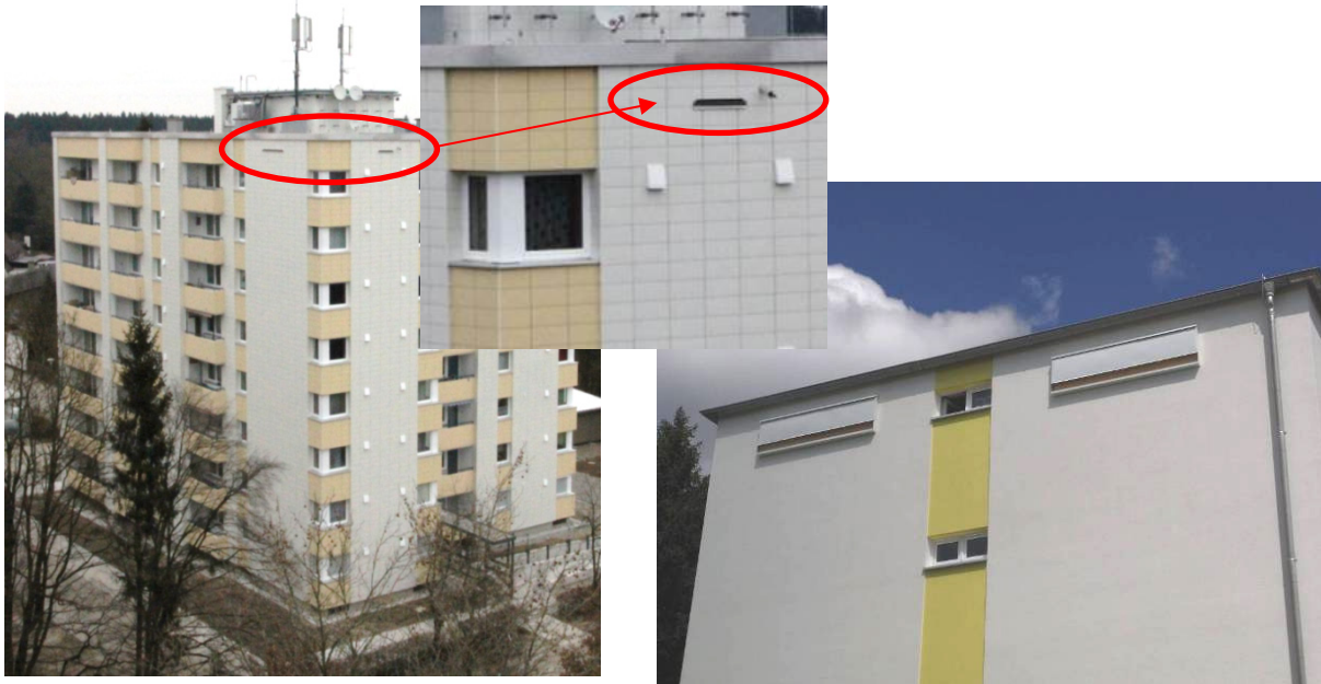
Abb. 26: Abendseglerersatzquartiere in Waldkraiburg. Einbau in eine Fassade (links), Anbringung von Kästen (rechts).
