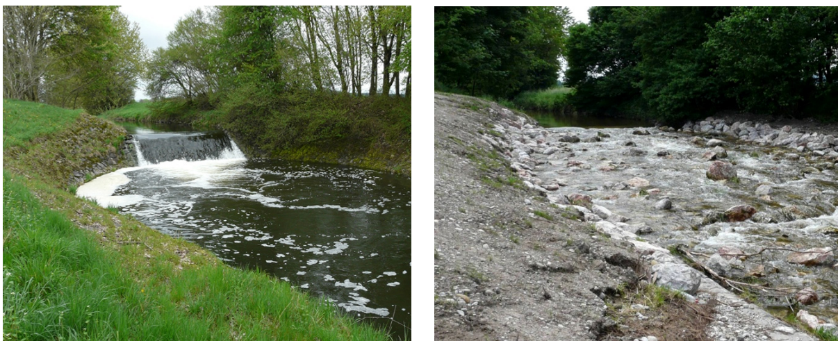
Abb. 2: Typische Sohlschwelle in der Mindel vor und nach einer Renaturierungsmaßnahme (rechts)
