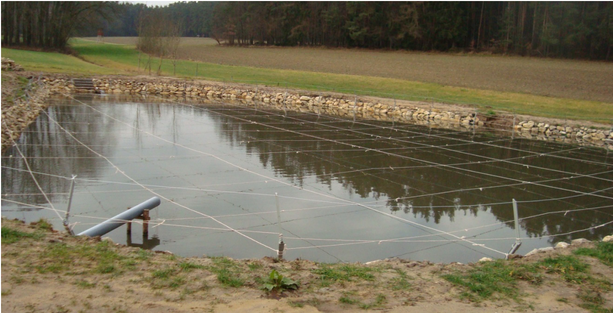
Abb. 8: Überspannter Winterungsteich. Die Konstruktion macht einen stabilen Eindruck, allerdings birgt die große Anzahl an Kreuzungspunkten eine erhöhte Gefahr für größere Wasservögel (siehe Abb. 11).
