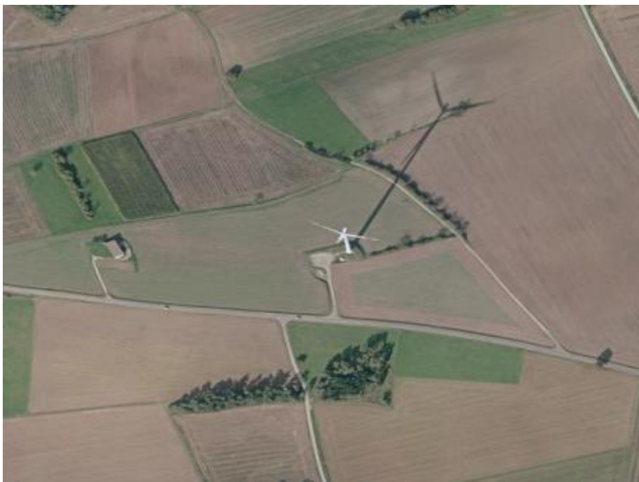
Abb. 7: Luftbildaufnahme der untersuchten Anlage bei Tiefenhöchstadt
