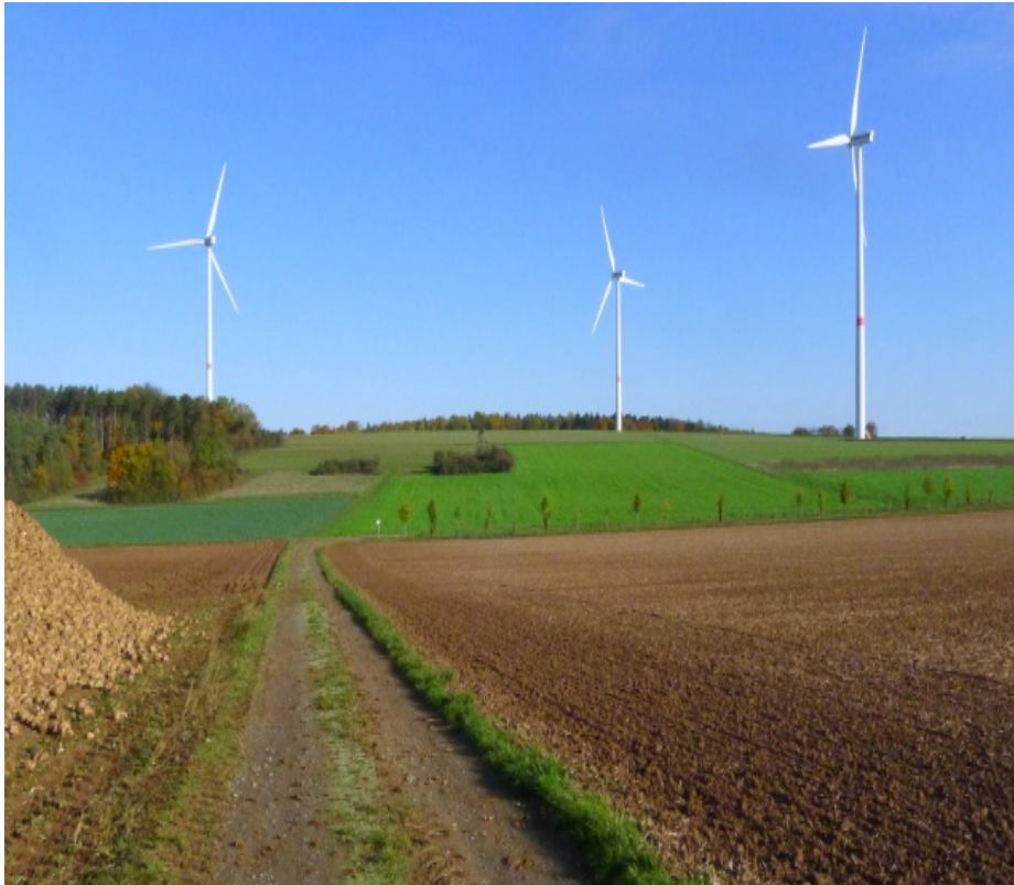
Abb. 16: Blick auf die Anlagen bei Urspringen
