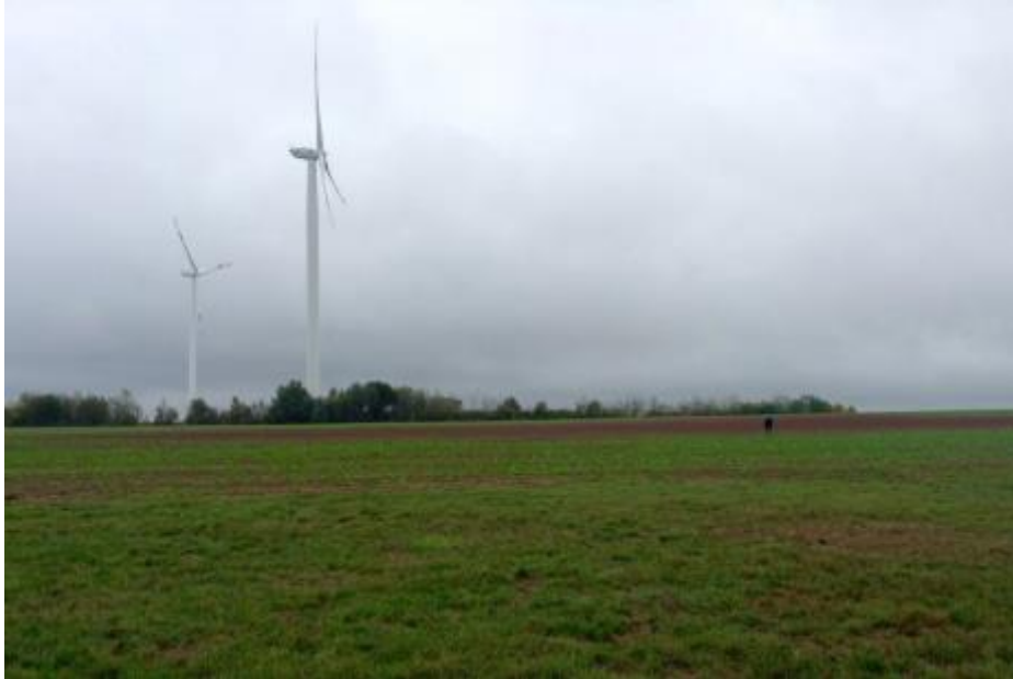
Abb. 20: Blick auf die Untersuchungsfläche Windpark Emskirchen
