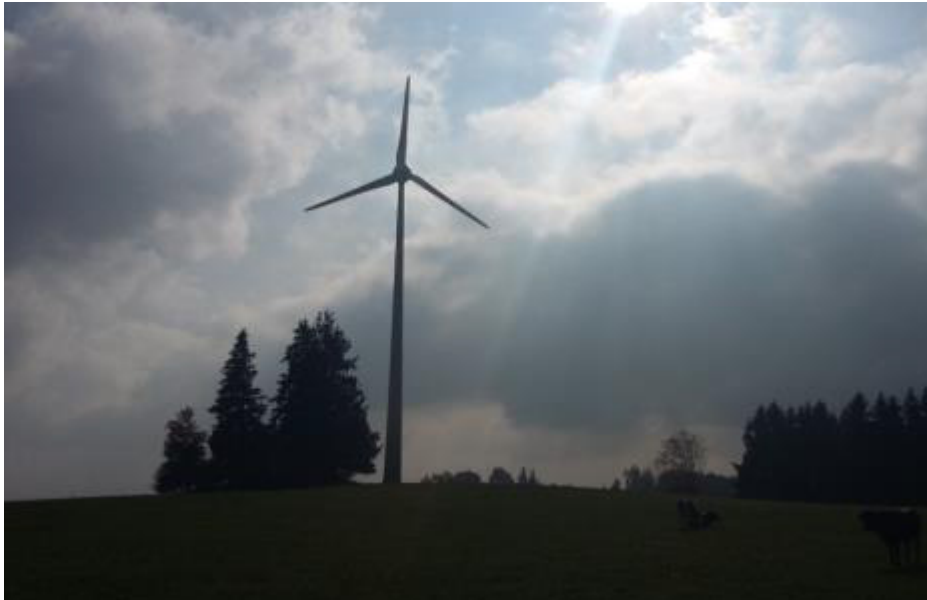
Abb. 25: Blick auf eine Anlage bei Salenwang
