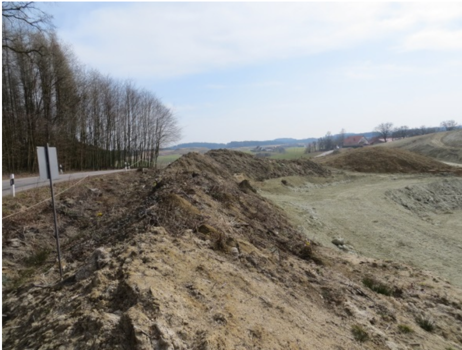
Abb. 2: Zwischenlagerung von Bodenabraum ver- schiedener Schichten beim Bentonitabbau
