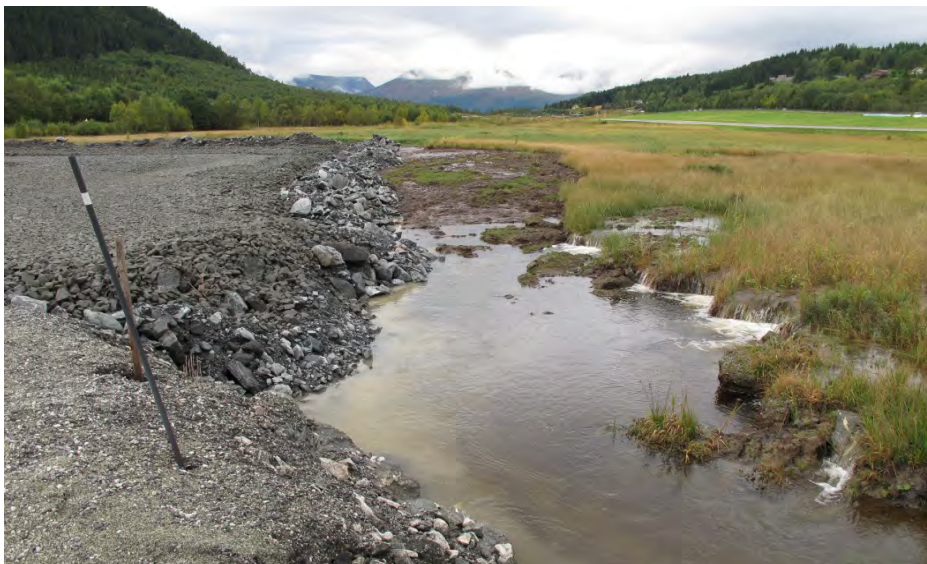
Abb. 55: Verfüllung eines Feuchtgebietes mit Veränderung im Wasserhaushalt und rück-schreitender Erosion im Niedermoor. Foto: Heiko Liebel.
