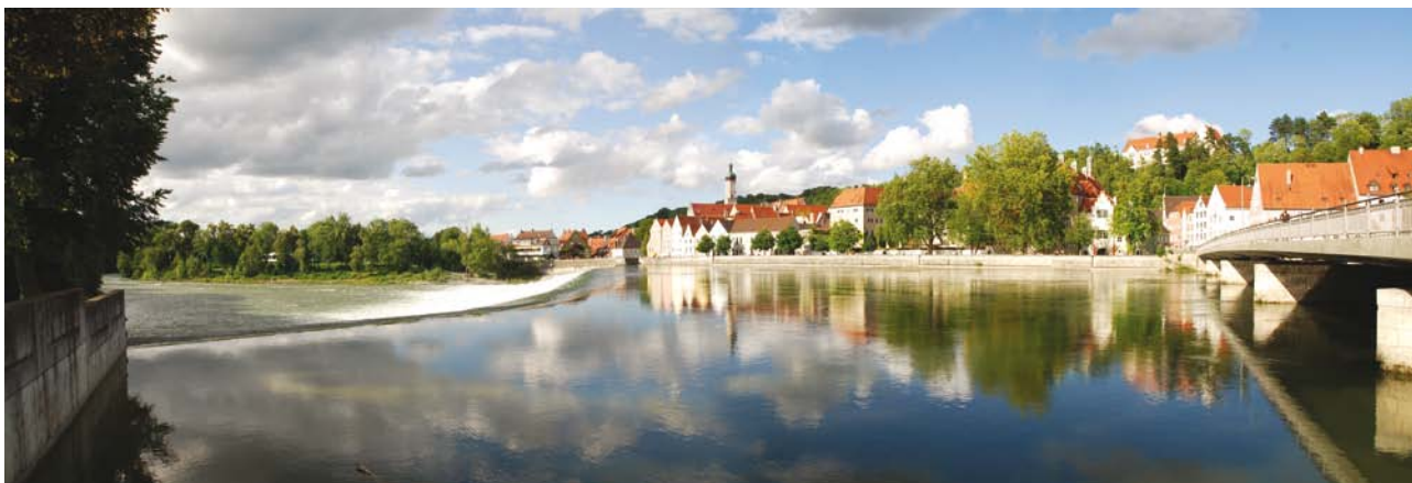
Lechwehr mit Karolinenbrücke in Landsberg am Lech
