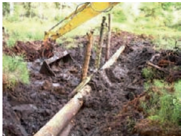
4. Einbau der weiteren Stammhölzer, gleichzeitig abschnittsweise Torfhinterfüllung, -Verdichtung, Sodenabdeckung
