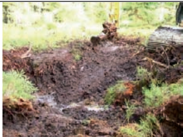
1. Freilegen des anstehenden Substrats
