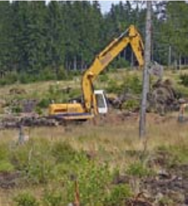
Feuchtgebietsrenaturierung und Tümpelanlage durch den Forstbetrieb Fichtelberg
