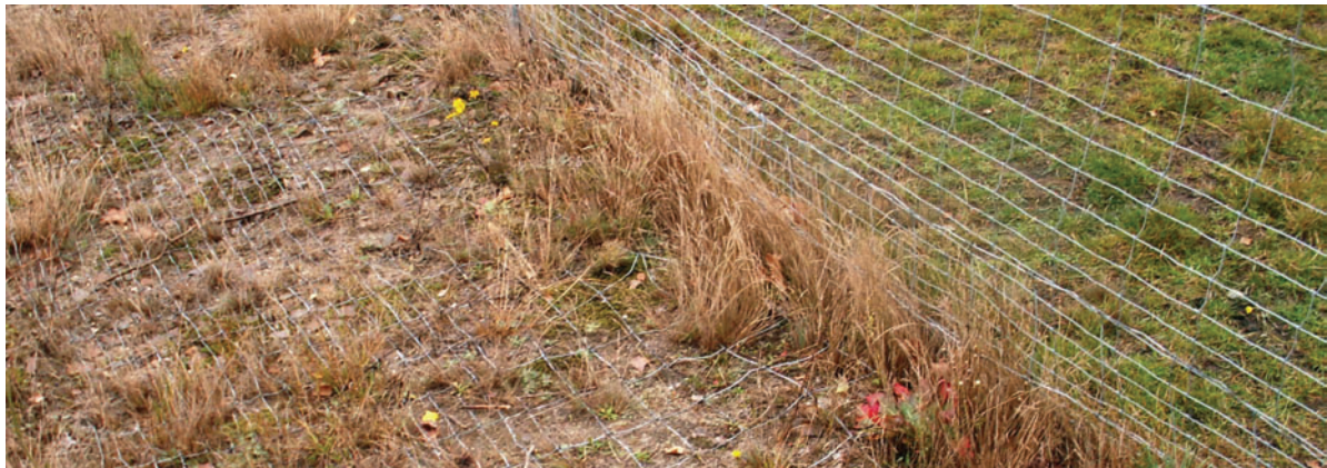
Abbildung 24: Das Anbringen einer Zaunschürze verhindert das Untergraben von nichtelektrifizierten Zäunen.
