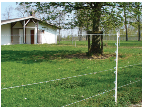
Abbildung 6: Die unterste Litze ist nah genug am Boden angebracht, jedoch ist der Abstand zur obersten Litze zu groß.
