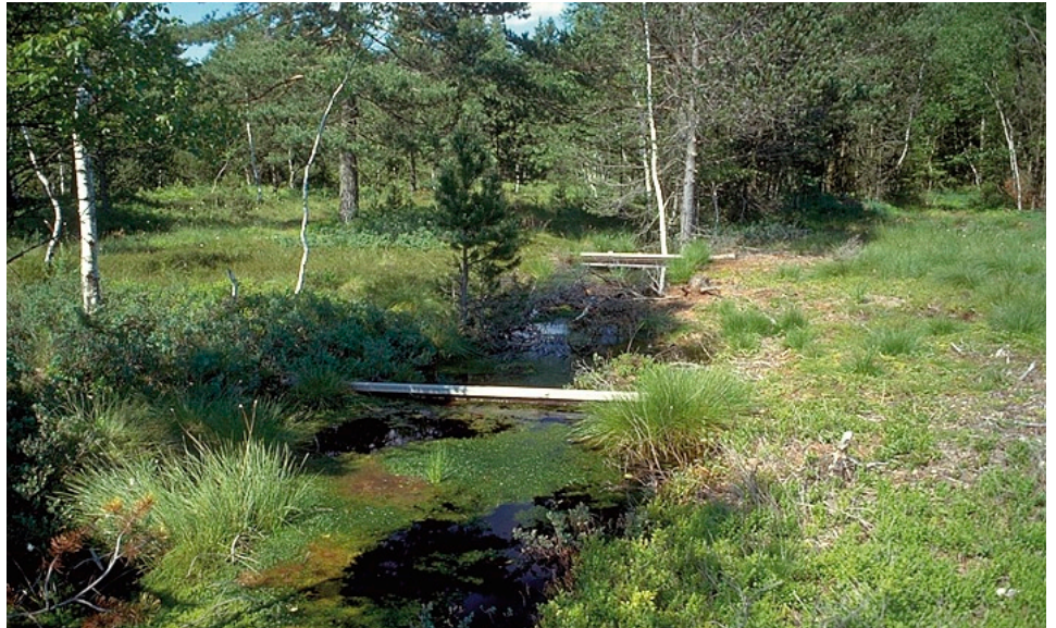
Anstaumaßnahme im Breiten Moos (Lkr. Landsberg/Lech, Foto: Hubert Anwander)
