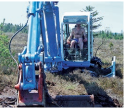
Grabenverschluss mit moortauglichem Bagger
