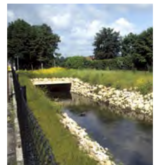
Im Einzelfall können Uferbereiche, z. B. der Auslauf einer Kläranlage, versteint werden, so dass Biber keine Röhren graben können.
