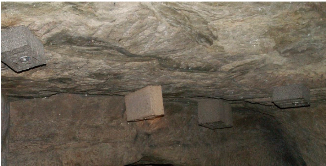
Abb. 36: Anbringen von Hohlblocksteinen im Fledermauskeller.
