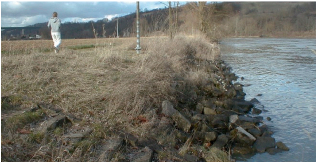
Abb. 10: Verbautes Ufer vor der Umgestaltung.
