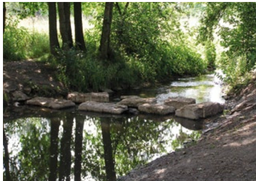
Abb. 63 (unten links): Wiederherstellung der Durchgängigkeit an einem Sandfang.
