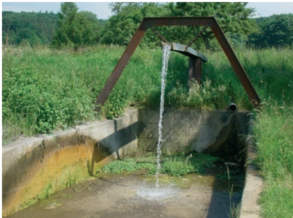
Abb. 41: Quellbachverrohrung zur Befüllung von Wassertanks im Lkr. Roth
