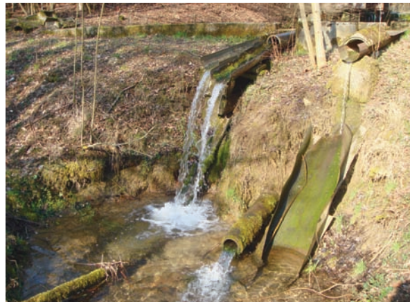
Abb. 42: Absturz an Quellbach unterhalb eines Teiches im Lkr. Bayreuth
