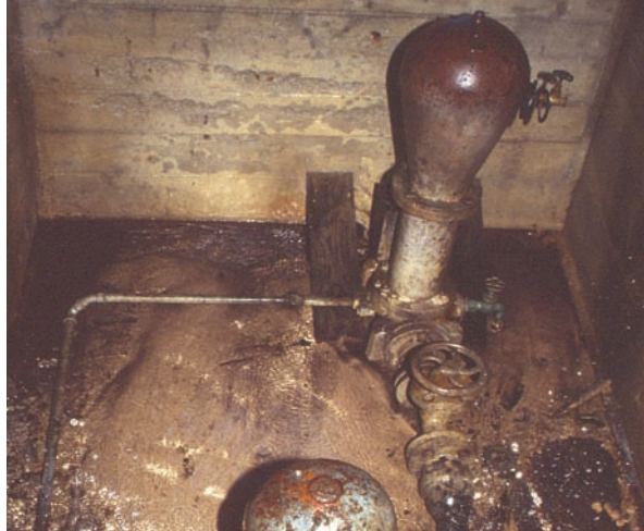
Abb. 19: Hydraulischer Widder zur Wasserbeförderung von der Quelle zu einem höher gelegenen Ort
