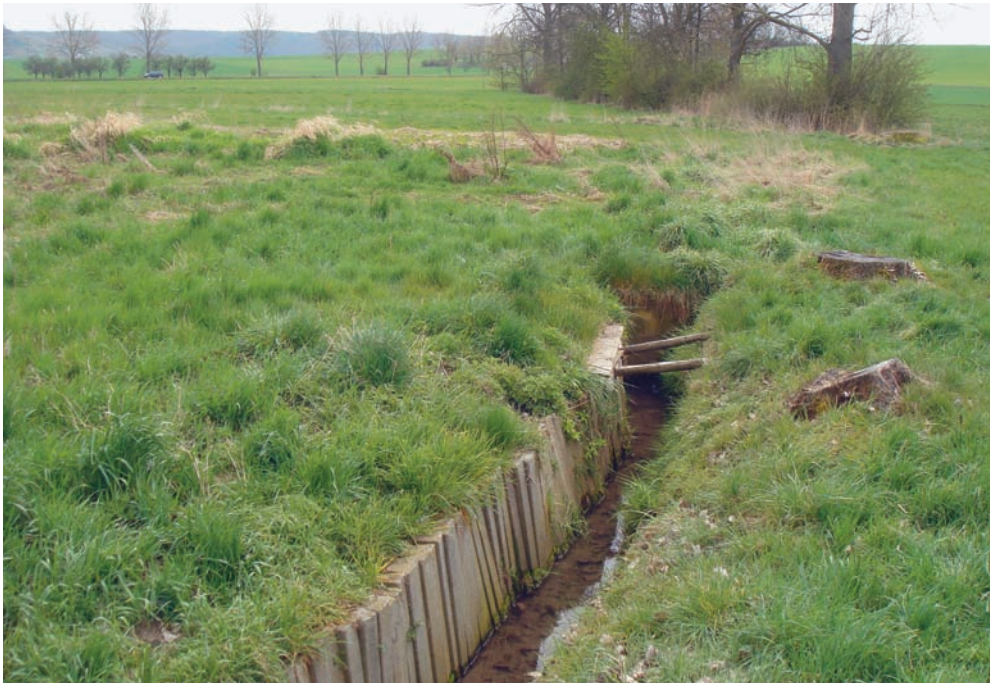
Abb. 58: Entwässerungsgraben bei Ipsheim mit Uferverbauung und ohne Quellstrukturen (Lkr. Neustadt a.d.Aisch - Bad Windsheim)
