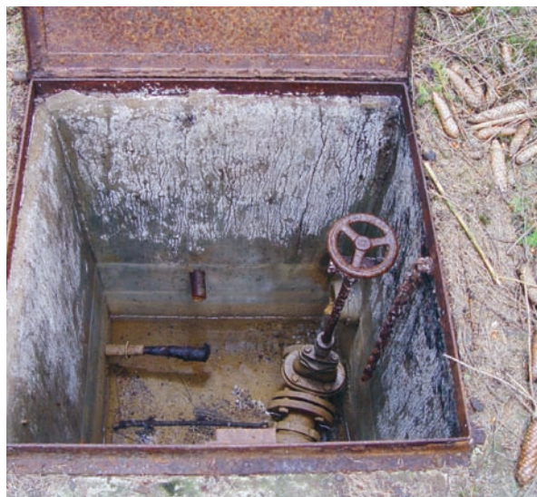
Abb. 24: Blick ins Innere eines Quellsammlers, Lkr. Nürnberger Land
