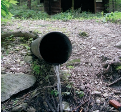
Abb. 43: Quellverrohrung im Zuge des Wegebbaus am Hetzles im Lkr. Forchheim
