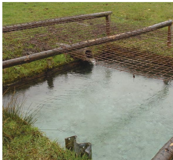
Abb. 53: Verrohrte und zur Fischzucht genutzte Quelle bei Aschau i.Ch., Lkr. Rosenheim
