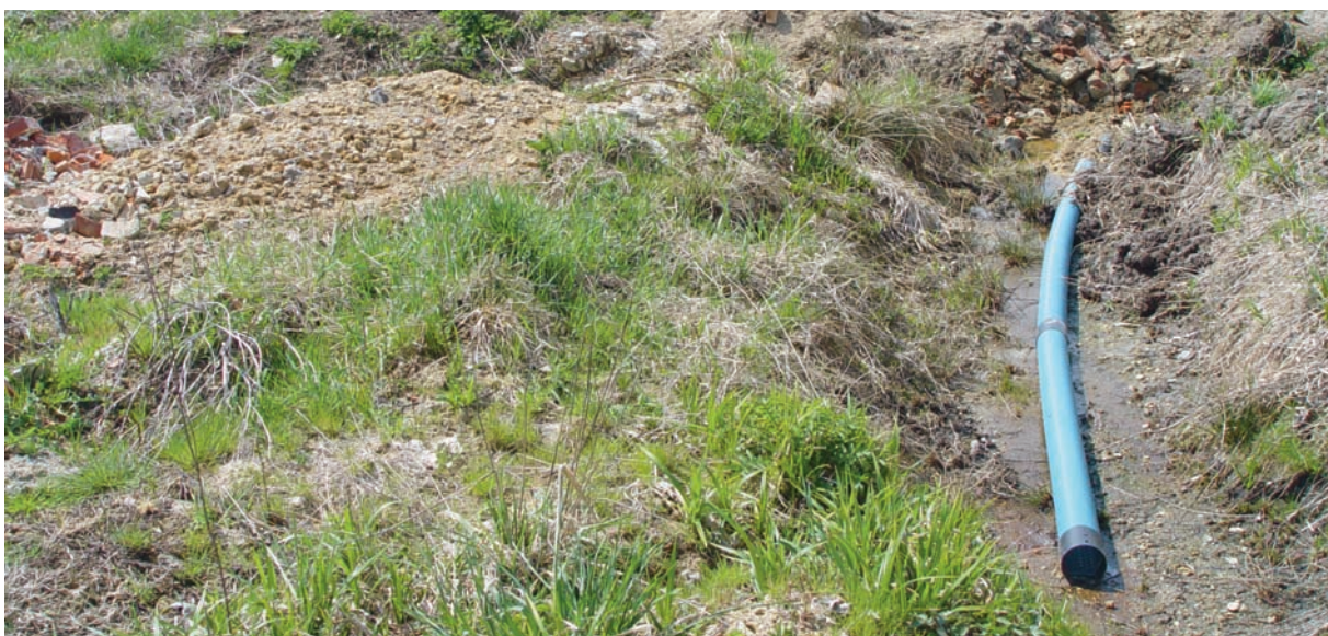
Abb. 37: Verlegung einer Dränage in Feuchtbrache im Bayerischen Wald, Lkr. Freyung-Grafenau
