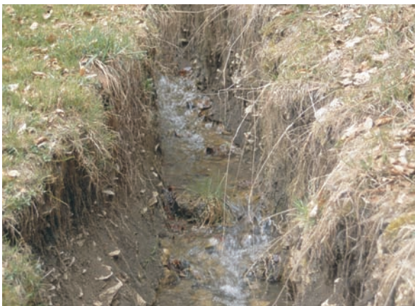
Abb. 55: Ausgeräumter Kalktuff-Quellbach bei Tiefenstürmig im Lkr. Forchheim
