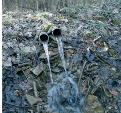
Abb. 44: Quellverrohrung im Zuge des Wegebbaus bei Greding im Lkr. Roth
