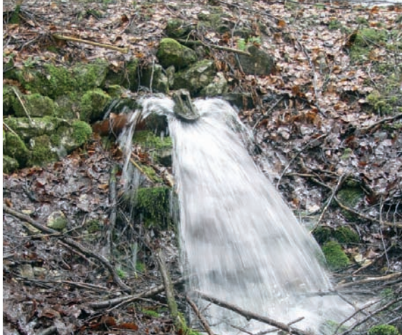
Abb. 18: Überlauf aus Quellfassung, Lkr. Rosenheim
