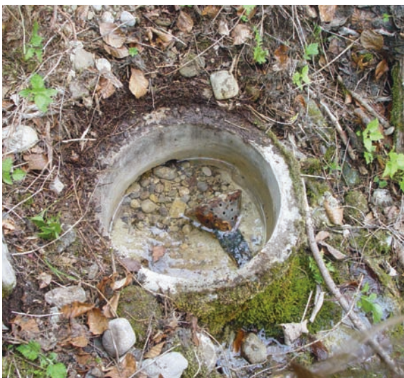
Abb. 23: Blick ins Innere einer kleineren Quelfassung, Lkr. Unterallgäu
