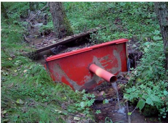
Abb. 16: Querbauwerk mit Absturz an einem Quellabfluss
