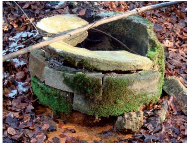
Abb. 13: Verfallene Quellfassung, entspricht mittlerer Ausprägung
