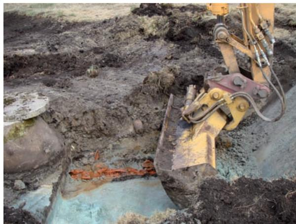
Abb. 50 (links): Rückbau eines Drainagesystems aus einem ehemaligen Sickerquellbereich bei Oberbrunn (Lkr. Traunstein); Abb. 51 (rechts): Neben dem Rückbau einer Quellfassung wurden im NSG Georgenberg zwei Drainageschächte gekappt (Lkr. Neustadt/Waldnaab)
