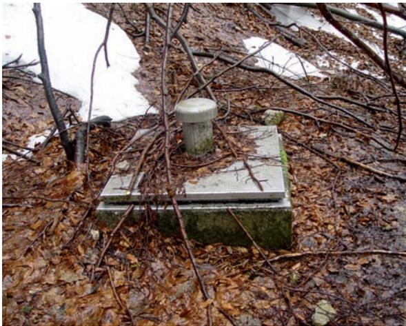
Abb. 12: Quellfassung zur Trinkwassergewinnung, entspricht starker Ausprägung
