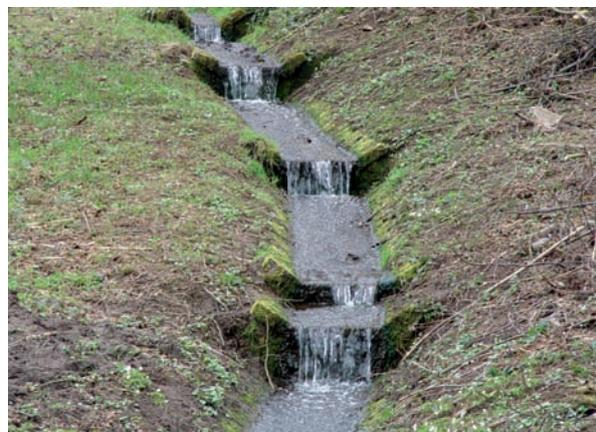
Abb. 17: Sohlverbau mit Abstürzen im Quellabfluss
