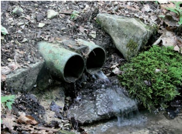
Abb. 14: Verrohrung des Quellabflusses
