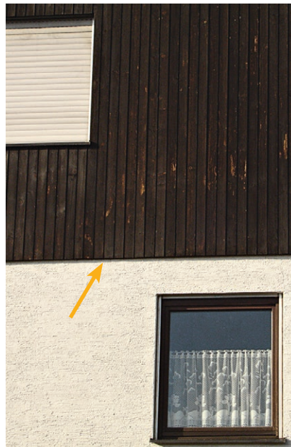
Abb. 13 (links): Holzverkleidung an einem Einfamilienhaus. Die Einschluflmöglichkeit befindet sich zwischen Holzverkleidung und Hauswand.
