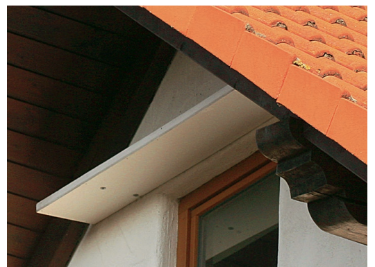
Abb. 34: Kotbrett unter dem Quartier einer Kolonie Zwergfledermäuse in einem Wohnhaus. Das Quartier befindet sich zwischen Balken und Hauswand.
