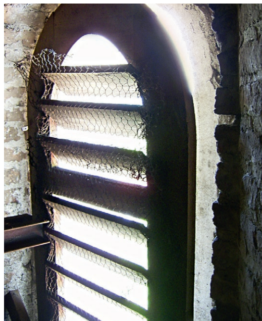
Abb. 48 (oben links): Die großen Öffnungen im Bereich der Glocken sind die Schallluken. Sie sind normalerweise mit Lamellen versehen.
