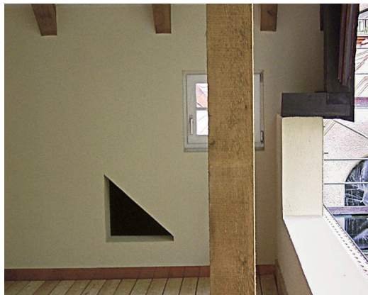
Abb. 57 (links): An dieser Dachterrasse wurde eine zusätzliche (dreieckige) Öffnung zu dem dahinterliegenden Dachboden geschaffen.
