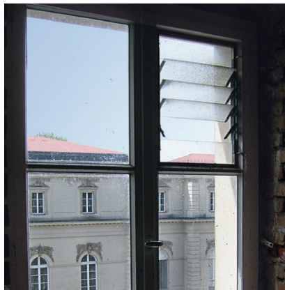
Abb. 44 (links): Ein dauerhaft offener und gleichzeitig taubensicherer Zugang für Fledermäuse zum Dachboden des Schlosses Herrenchiemsee.
