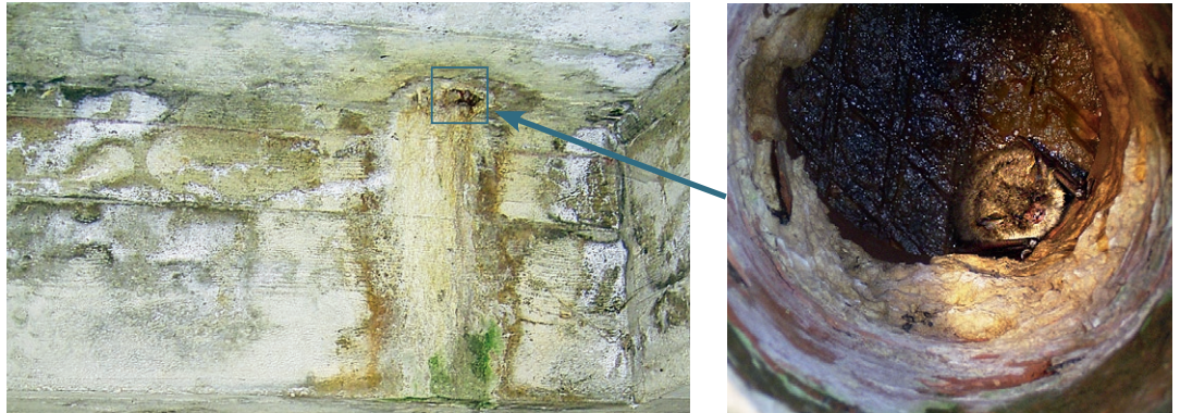
Abb. 32, 33: Fledermausquartier in einem Abflussloch unter einer Betonbrücke. Der Blick hinein verrät: Hier lebt eine Fransen- fledermaus.
