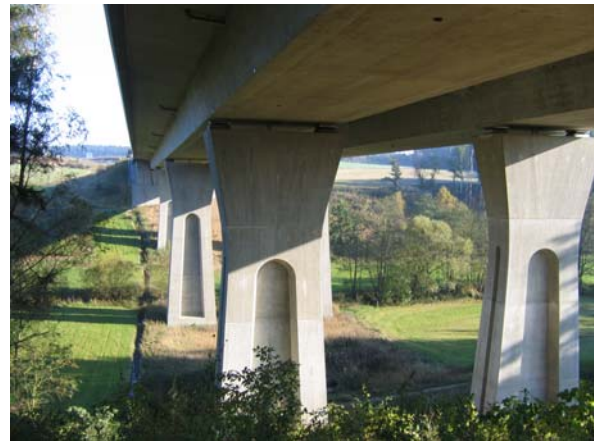
Typ A: Talbrücke an der A93 bei Marktredwitz
