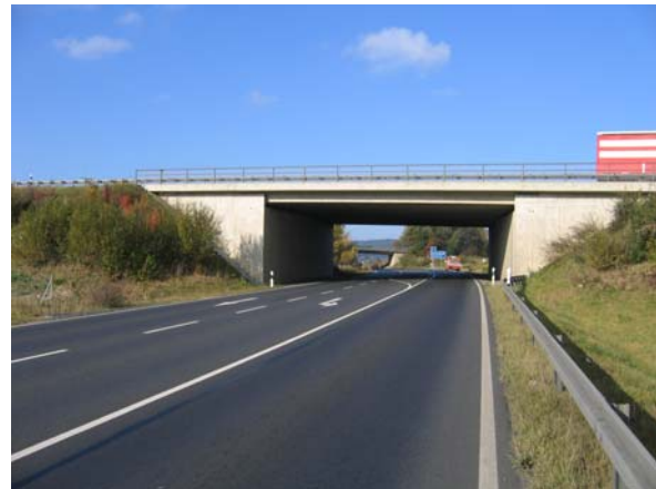
A93 bei Windischeschenbach: ungeeignet wegen der darunter führenden Kreisstraße.
