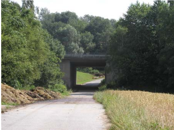
Beispiel für eine schmale Waldwegeunterführung vom Typ E an der A3 bei Passau
