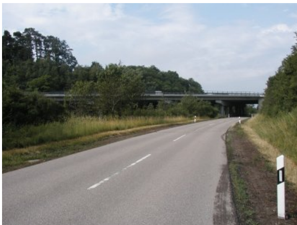
Brücke an der A6 über die Bahnlinie Stuttgart-Nürnberg und eine Kreisstraße bei Oberampfrach: Herabstufung von Typ B auf D wegen Unterteilung der Brücke und Länge von 77 m.
