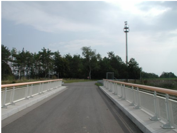
Überführungen wie diese Brücke über die A73 bei Coburg ohne Deckung sind für Wildtiere ungeeignet . Blendschutzeinrichtungen und Gestaltung als Kombibauwerk (Teilentsiegelung) könnten die Eignung als Querungshilfe deutlich verbessern.
