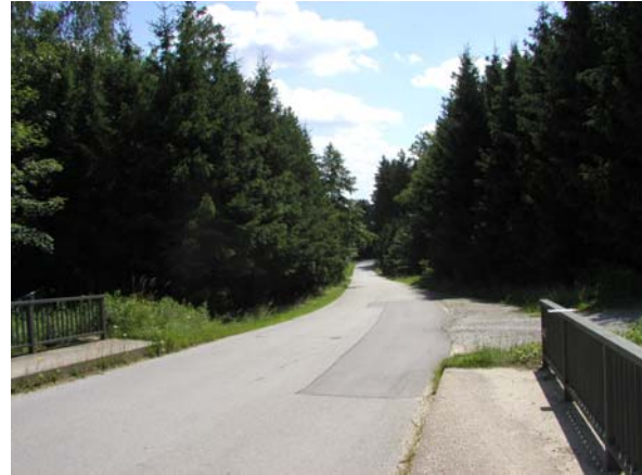
Typ E: Bei guter landschaftlicher Einbindung können auch Überführungen für einige Tierarten als Querungshilfen dienen (A3 bei Passau)
