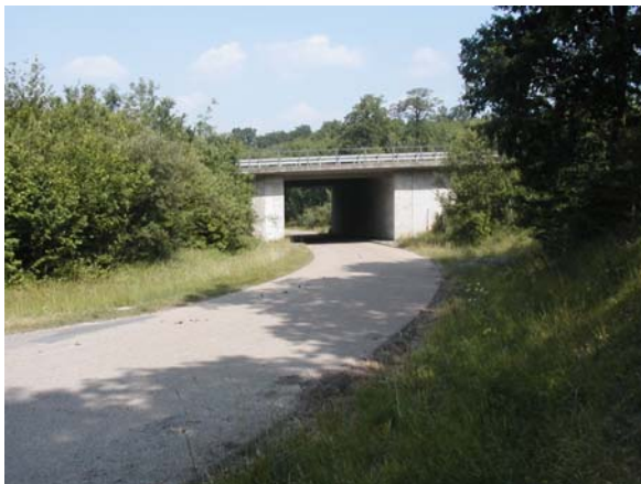
Brücke über eine Ortsverbindungsstraße an der A6 bei Schnelldorf: Aufwertung von Kategorie D auf C wegen beidseitiger guter Deckung.
