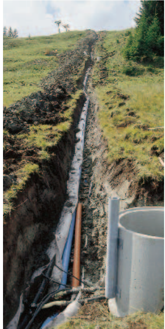
Foto 34: Rohrleitungen und Zapfstelle einer Beschneiungsanlage im Bau (Skigebiet OA11 Gunzesried/Ofterschwang).
