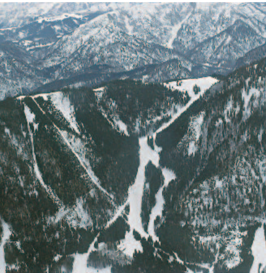
Foto 5: Gerodete Bahntrassen und Pisten im Skigebiet TS08 Unternberg.
