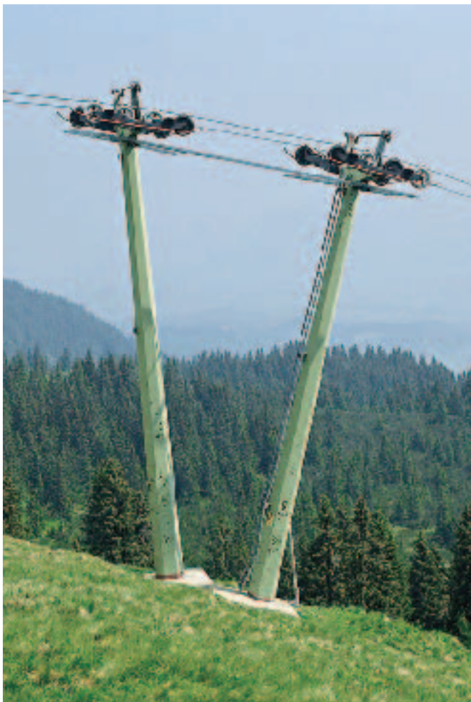
Foto 26: Stützmasten eines Schlepplifts (TS05 Winklmoosalm).
