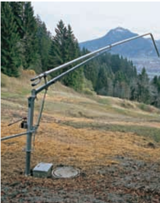
Foto 35: Schnee-Lanze eines Hochdrucksystems mit Zapfstelle für Wasser, Druckluft und Strom (OA11 Gunzesried/Ofterschwang).
