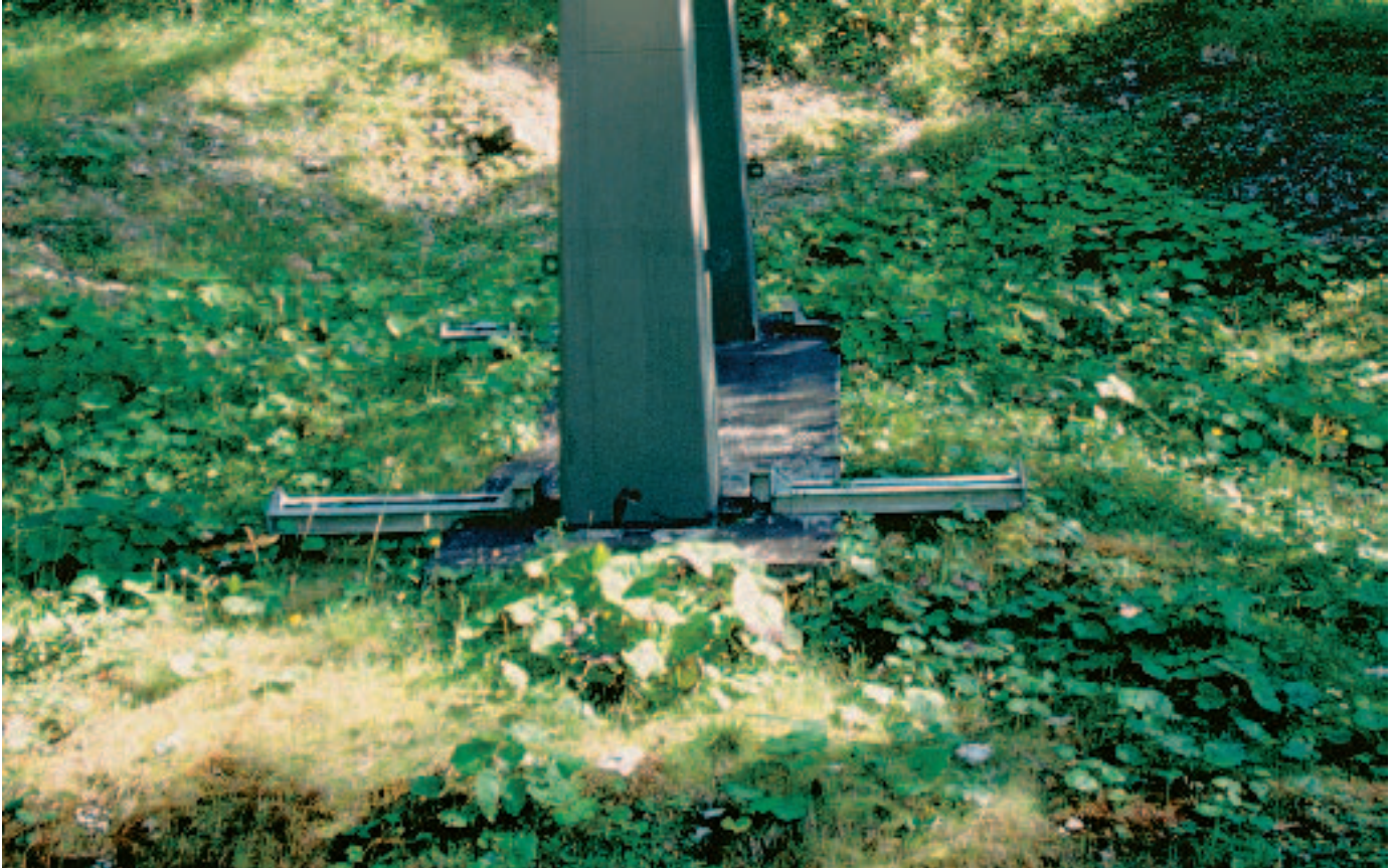
Foto 68: Hufattich-Pestwurzflur an einer Liftstütze. Dieser Vegetationstyp tritt auf Planierungen dann auf, wenn durch Oberflächenabfluss oder durch Bodenbewegung Bodenabtrag stattfindet (GAP06 Alpspitz/Hausberg/Kreuzeck).
