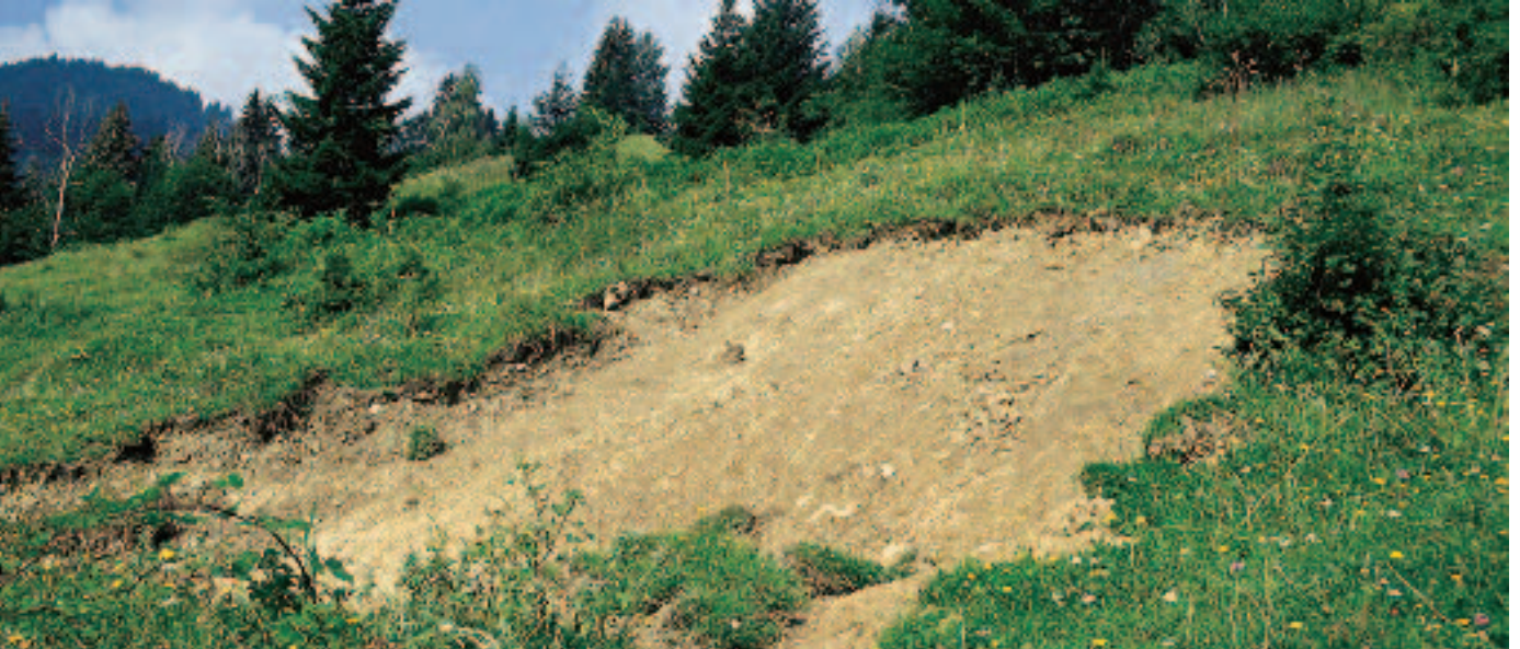
Foto 88: Sackung in einer baulich veränderten Fläche.
