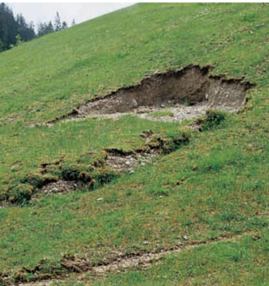
Foto 86: Rutschung in einer Skipiste.
