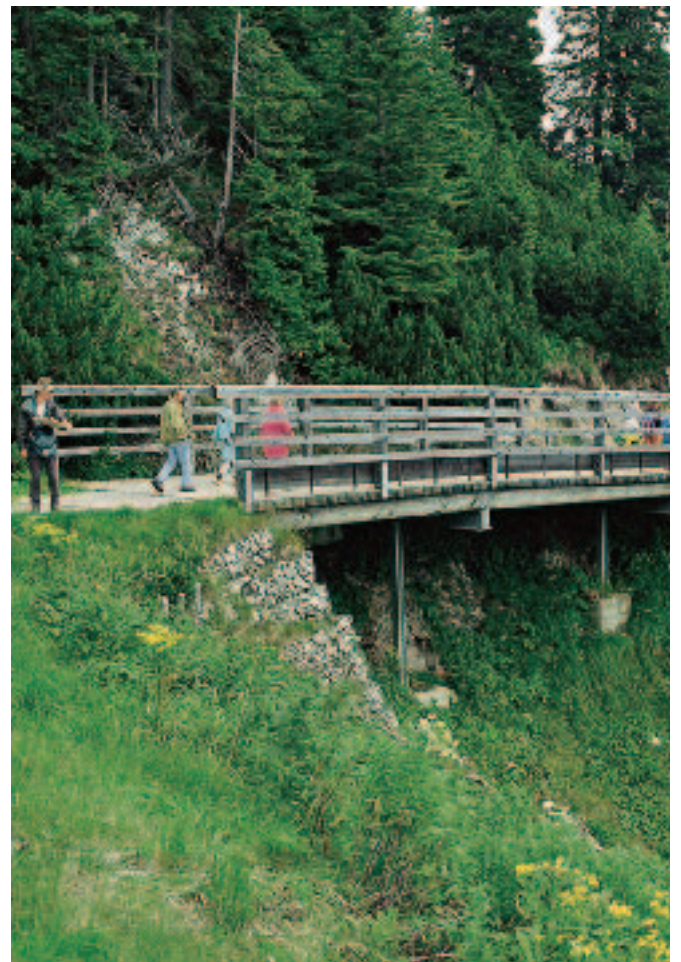
Foto 30: Diese Konstruktion ermöglicht die Passage einer Skipiste an einer Engstelle (BGL01 Predigtstuhl).
