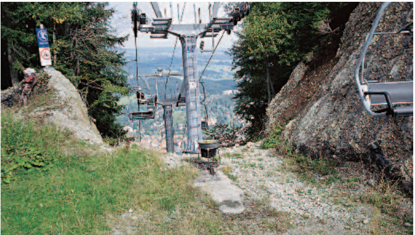
Foto 39: Felssprengung in einer Bahntrasse (OA08 Mittag Skicenter).
