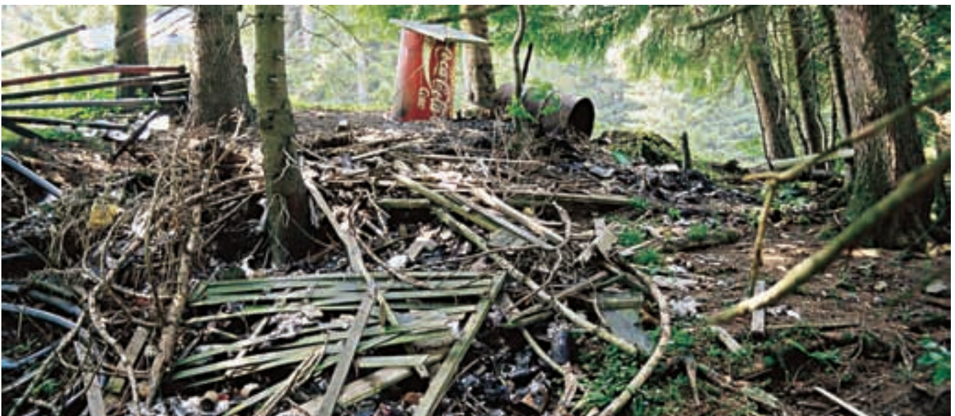
Foto 81: Ablagerung von Schrott und Baumaterialien neben den Pisten.
