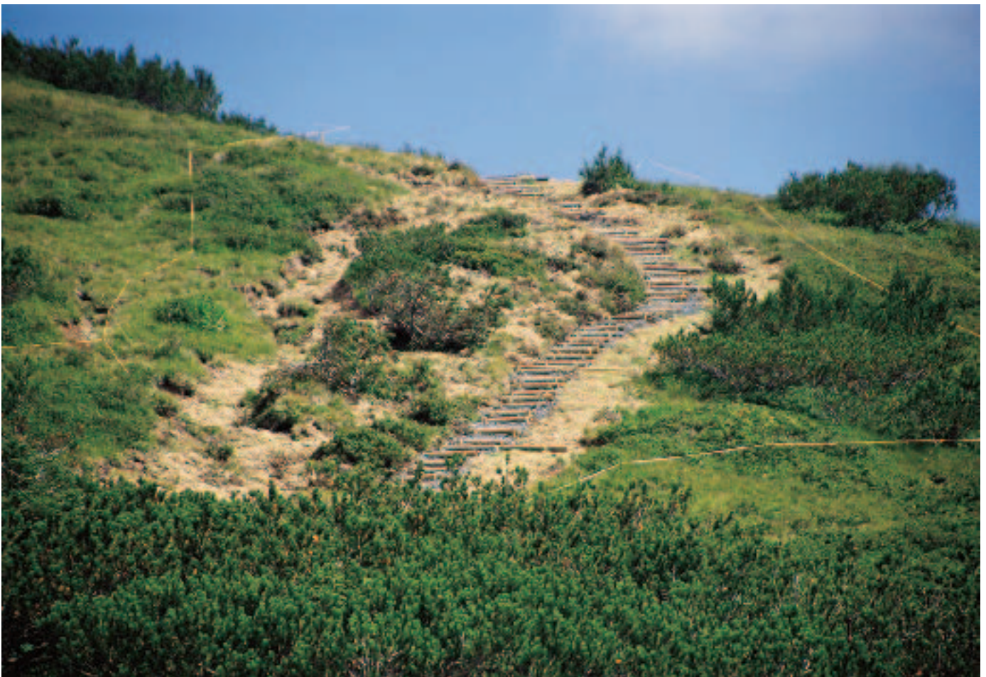
Foto 97: Sanierter Wanderweg (OA16 Fellhorn).
