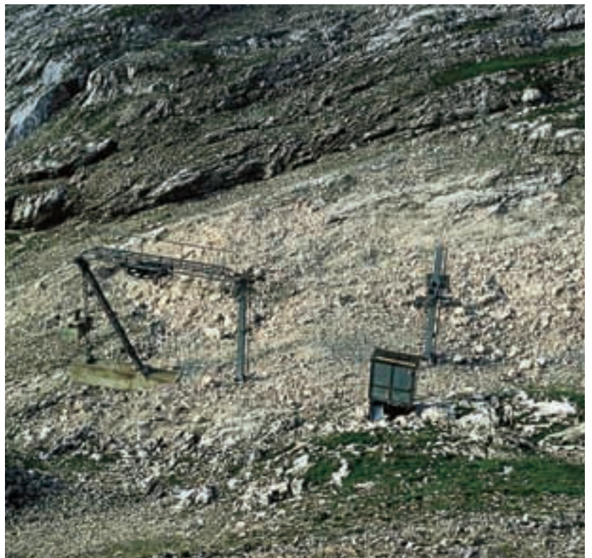
Foto 42: Felssprengung und Planierung an der Bergstation eines Schlepplifts (GAP05 Zugspitze).
