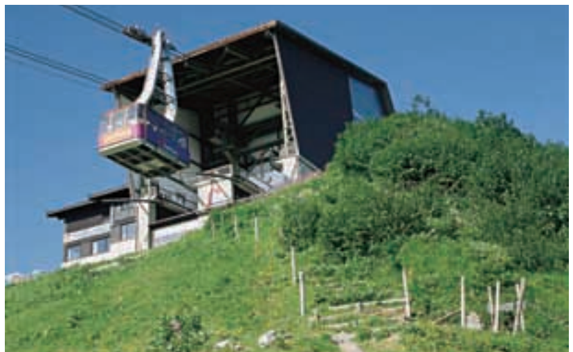
Foto 23: Stationsgebäude einer Seilbahn (OA16 Fellhorn).
