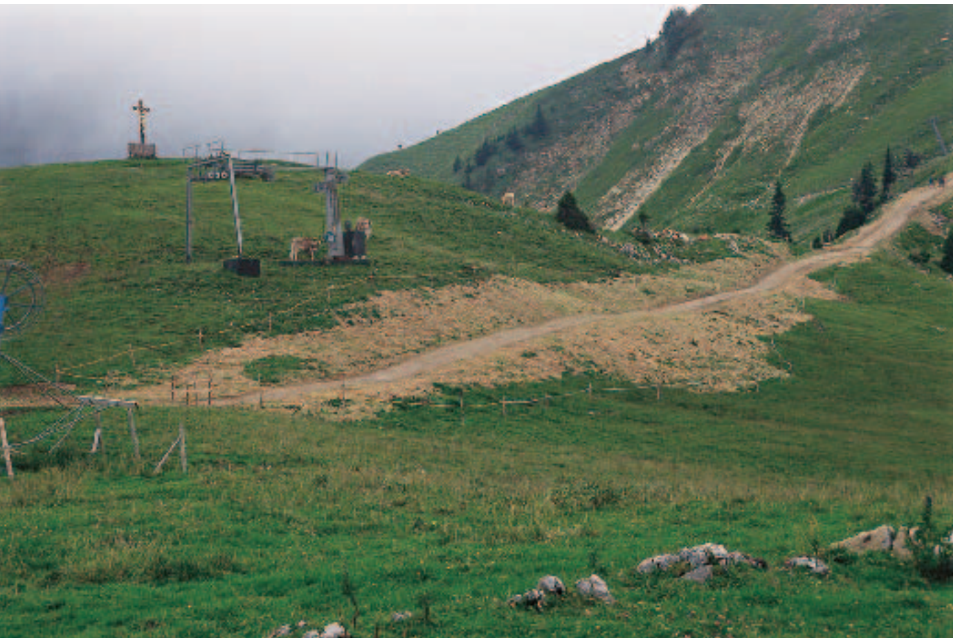
Foto 95: Beim Stroh-Deckschichtverfahren wird zum Schutz vor Witterungseinflüssen und Abspülung über das ausgebrachte Saatgut eine dünne Schicht Stroh ausgebracht (OAL02 Breitenbergbahn).
