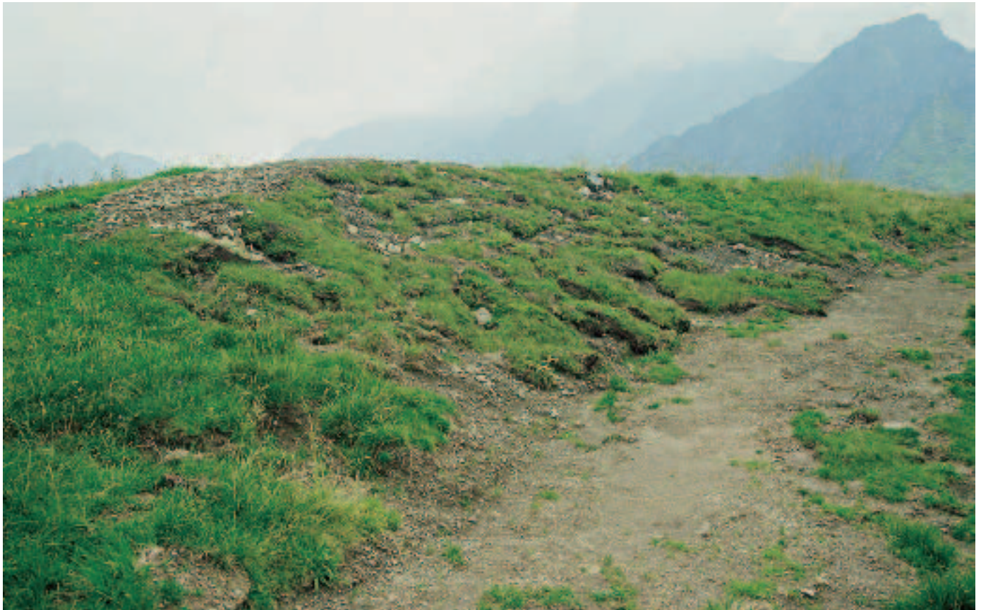
Foto 92: Die Verpflanzung von Rasensoden verbessert den Begrünungserfolg im Gebirge erheblich. Die Rasensoden müssen zu Beginn der Baumaßnahme abgetragen und zwischengelagert werden oder können in der Umgebung gewonnen werden (OA16 Fellhorn).
