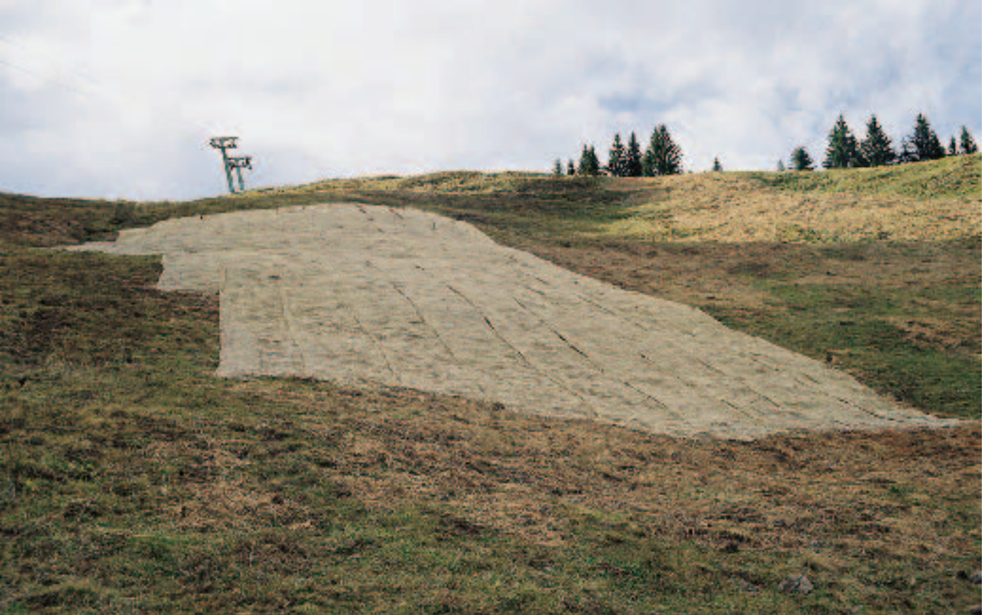
Foto 94: Jutematten stabilisieren die wieder aufgebrachte Humusdecke und verbessern den Begrünungserfolg, indem sie das Saatgut vor Witterungseinflüssen schützen. Sie verrotten innerhalb weniger Jahre (OA11 Gunzesried/Ofterschwang).
