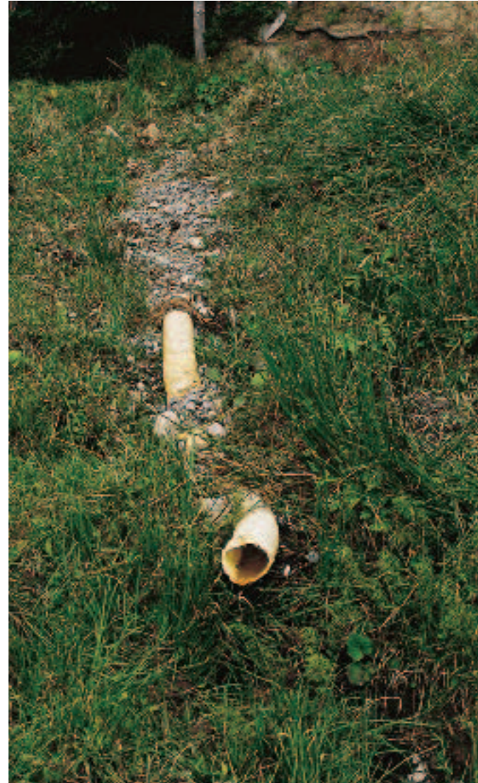
Foto 44: Drainagerohr in Drainagegraben (TÖL02 Brauneck).
