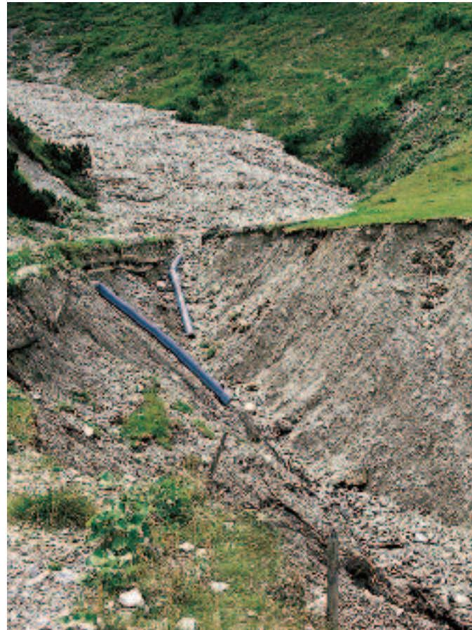
Foto 85: Massiver Erosionsschaden auf einer Skipiste.
