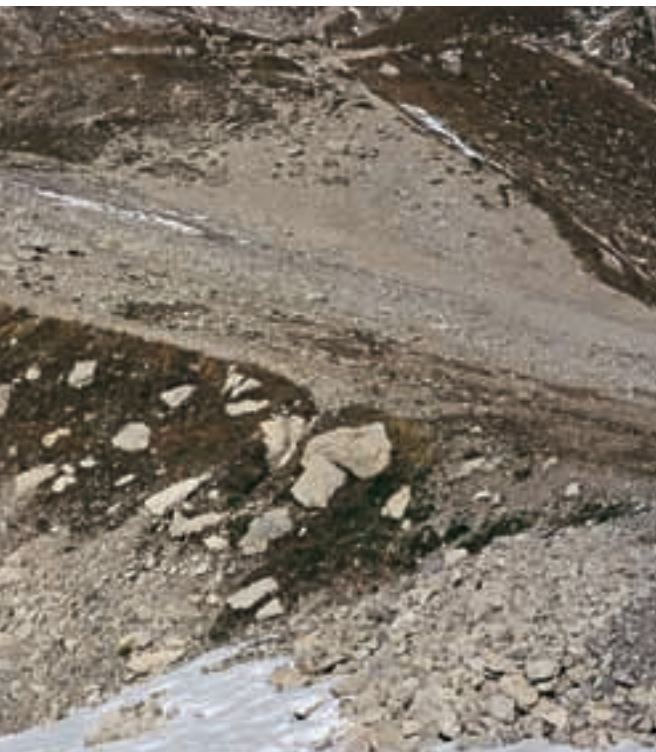
Foto 41: Typische Aufschüttung in einer Schleppliftrasse (OA17 Nebelhorn).
