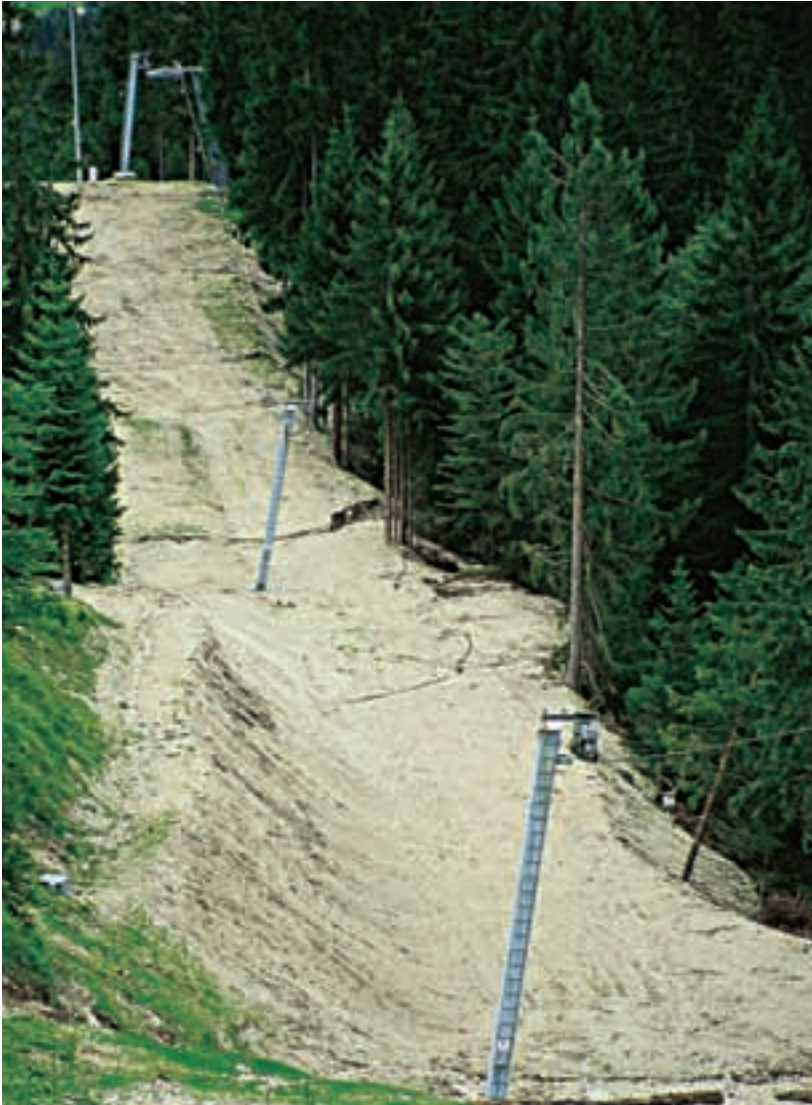
Foto 43: Baumaßnahmen in einer Bahntrasse: Planierung und Aufschüttung (BGL04 Göttschen).
