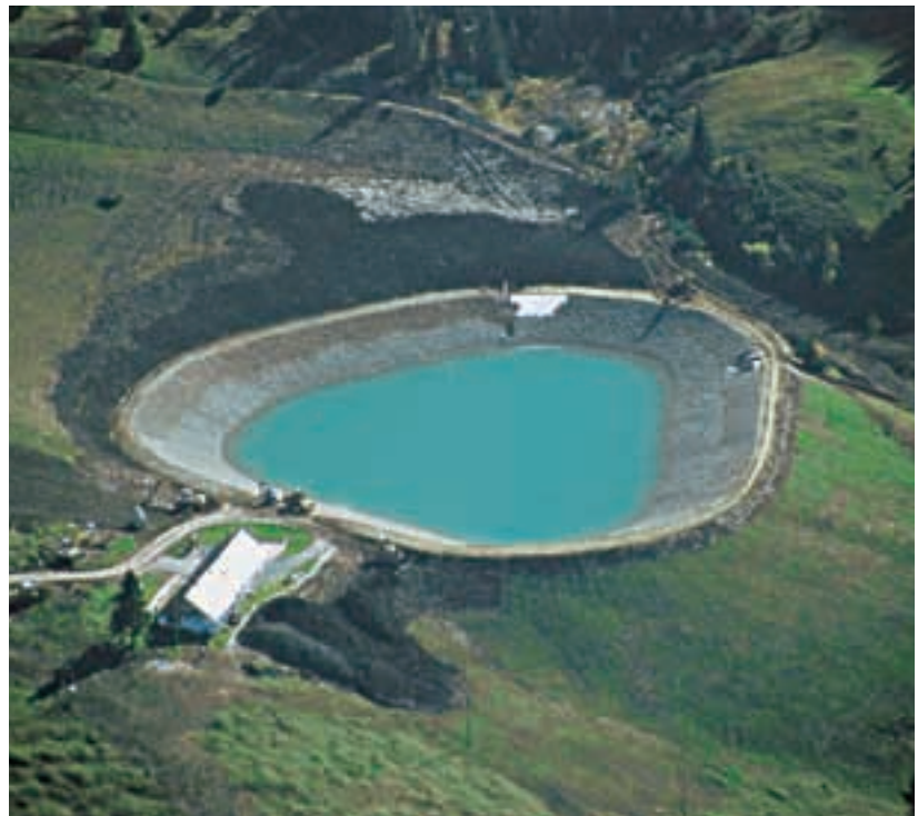
Foto 36: Speicherteich für eine Beschneiungsanlage (OA18 Oberjoch).
