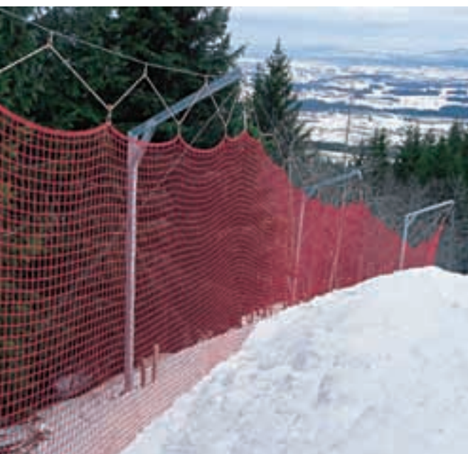
Foto 31: Diese Netze sichern den Pistenrand an Gefahrenpunkten (OAL01Alpspitzbahn).
