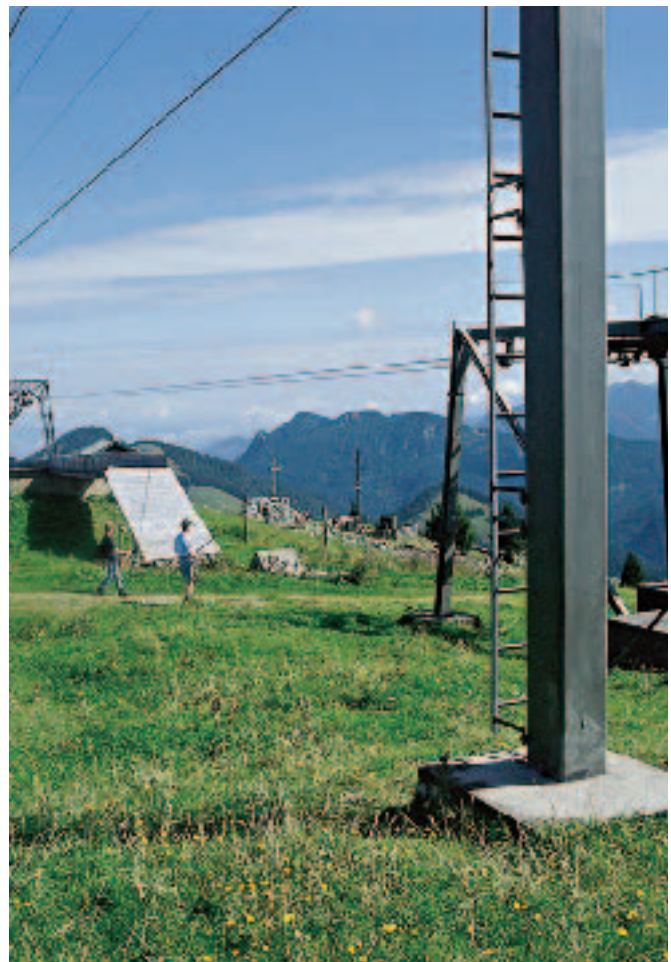
Foto 27: Bügelfangvorrichtungen an der Bergstation zweier Schlepplifte (MB04 Sudelfeld).
