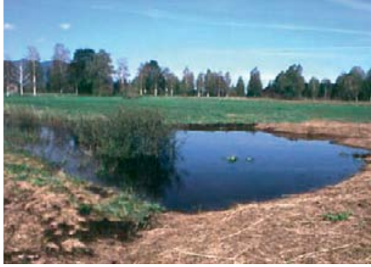
Abbildung 14: Umfeld eines Staubauwerkes mit Mähgutauftrag auf der Dammkrone. (Foto: E. Pleyl)
