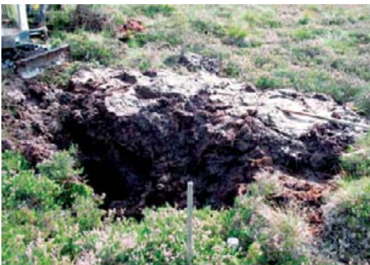
Abbildung 32: Damm vor Auftrag von Soden. Das Material entstammt dem oberstromigen Grabenprofil.
