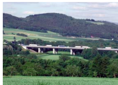
Bundesautobahn A 9 Talquerung bei Lanzendorf
