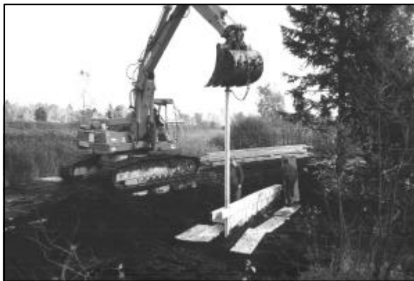
Foto 25. Einschlagen von massiven Holzspundwänden (Maßnahme 8.2.3).
