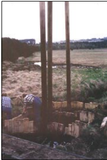
Foto 35. Einbau von massiven Holzspundwänden zur Sohlensicherung von Bächen im Randlagg (Maßnahme 8.3.4)
