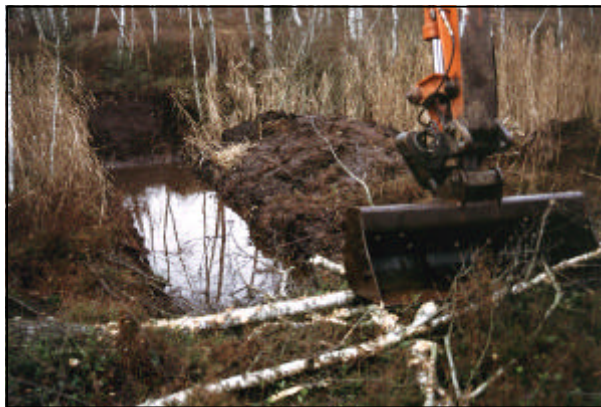
Foto 15. Maßnahme 8.2.1: Ausheben der Grabensohle vor Einbau des Holzgerüsts. Röthenbachfilz, Lkrs. Garmisch-Partenkirchen. 12/2000.
