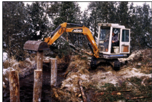
Foto 16. Einrammen der senkrechten Stützhölzer („Piloten“). Fotos 16-18: Sindelsbachfilz, Lkrs. Weilheim-Schongau. 1/2002.
