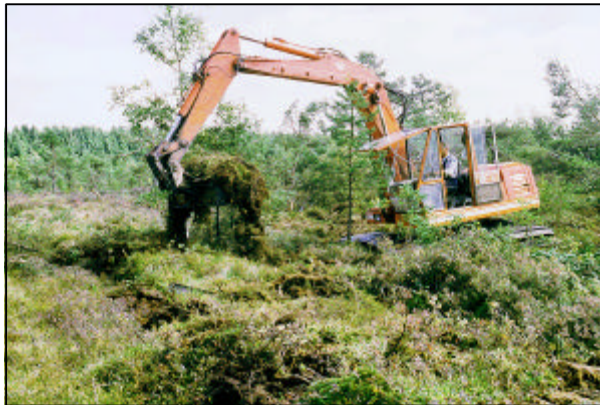
Foto 5. Verfüllung des Grabens: Sodenabdeckung zum Schluss
