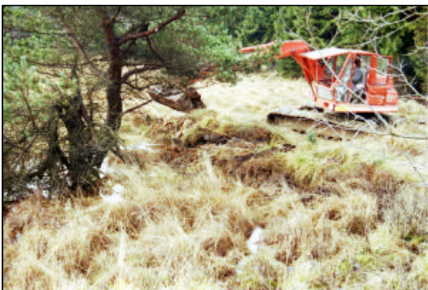
Foto 21. Verfüllung und Sodenüberdeckung an Stauwehr.
