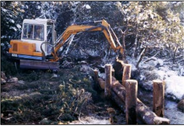
Foto 17. Einbau der querliegenden Rundhölzer.
