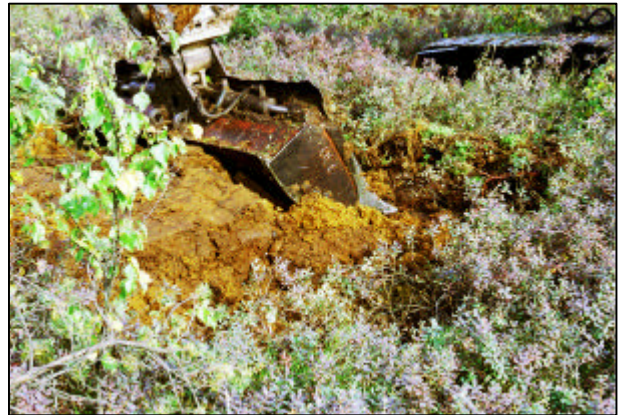
Foto 4. Eindrücken des Torfs zur Grabenverfüllung
