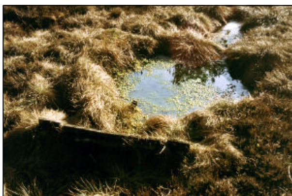
Foto 13. Maßnahme 8.1.3: Manuell eingebautes Holzbretterwehr mit Torfhinterfüllung an der Grabensohle. Anstauwirkung nur im direkten Grabenumgriff. Spatenbräufilz, Lkrs. Bad Tölz-Wolfratshausen. 12/2001
