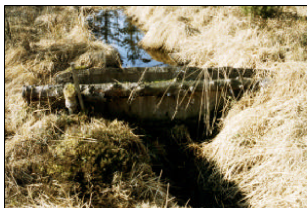
Foto 14. Maßnahme 8.1.3: Manuell eingebautes Wehr aus Nut- und Federbrettern mit Torfhinterfüllung an der Grabensohle. Anstauwirkung nur im direkten Grabenumgriff. Mühleckerfilz, Lkrs. Weilheim-Schongau. 12/2001
