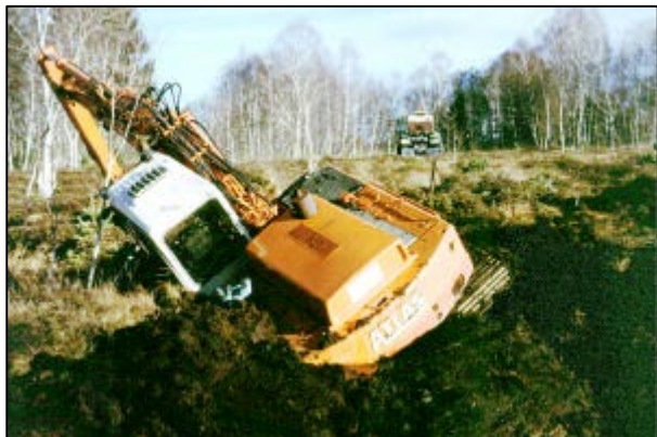
Foto 45. Bagger in altem Handtorfstich „versunken“ – er musste mit 2 Seilwinden und 2 Traktoren geborgen werden. Röthenbachfilze, Lkrs. Garmisch-Partenkirchen; 12/2000.
