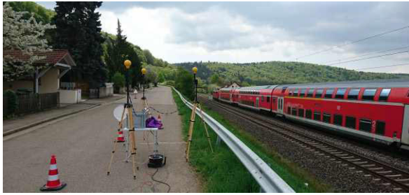
Abb. 37: Dieser Messpunkt wies in bislang allen Messreihen den höchsten Ausschöpfungsgrad für das niederfrequente elektrische Feld auf (MP256; Q_E = 500 \text{ ‰} ; Exposition durch die Energieversorgung der Bahn).
