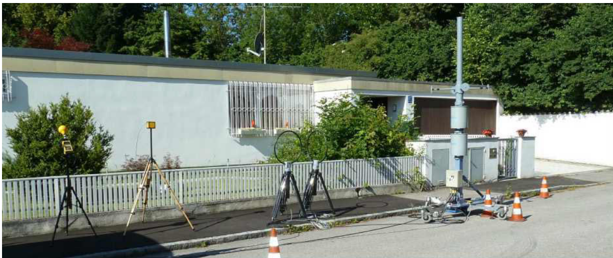
Abb. 5: Zum Vergleich der exemplarische Aufbau des alten Messsystems. Am Antennenturm von oben nach unten: Rundempfangsantenne HE309 (20 MHz – 1,3 GHz, vertikale Polarisationsebene), HE314A1 (20 MHz – 500 MHz, horizontale Polarisierungsebene), HF214 (500 MHz – 1,3 GHz, horizontal), sowie zwei Rundempfangsantennen HF902 (0,8 GHz – 3,0 GHz, horizontal und vertikal). Zusätzlich von links nach rechts: Niederfrequenzsonden für magnetische und elektrische Felder (5 Hz – 32 kHz) und zwei Loop-Antennen (9 kHz – 30 MHz). Ganz unten am Antennenturm ist der alte Umschalter für sieben Signalpfade zu erkennen.
