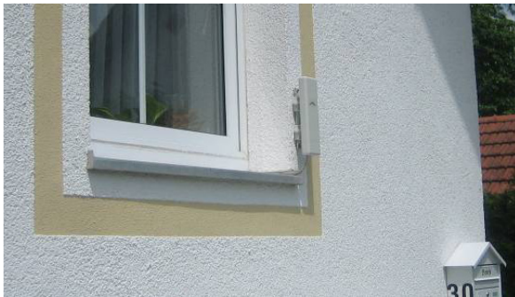
Abb. 2: Richtfunkantenne für Funk-DSL
