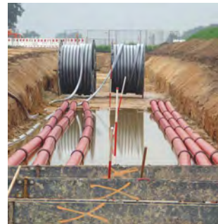
Abb. 18: Verlegung von 380 kV-Erdkabel auf einer Baustelle. Das Kabel wiegt ca. 40 kg pro Meter. Wegen der begrenzten Traglast der Lieferfahrzeuge sind die am Stück installierbaren Kabellängen auf ca. 500 bis 1.000 m begrenzt.
