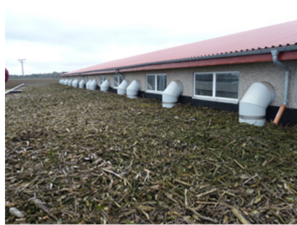
Abb. 8: Biofiltersystem aus dem Jahr 2012 für Ferkel-zucht (4.080 TP) mit Wurzelholz
