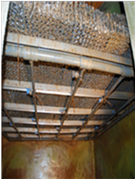
Abb. 36: Tropfenabscheider vor der Optimierung
