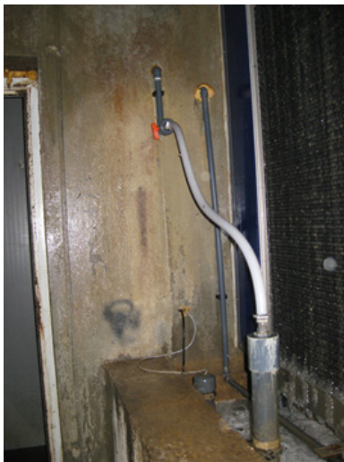
Abb. 20: pH-Wert Sonde mit automatischer Dosiereinrichtung
