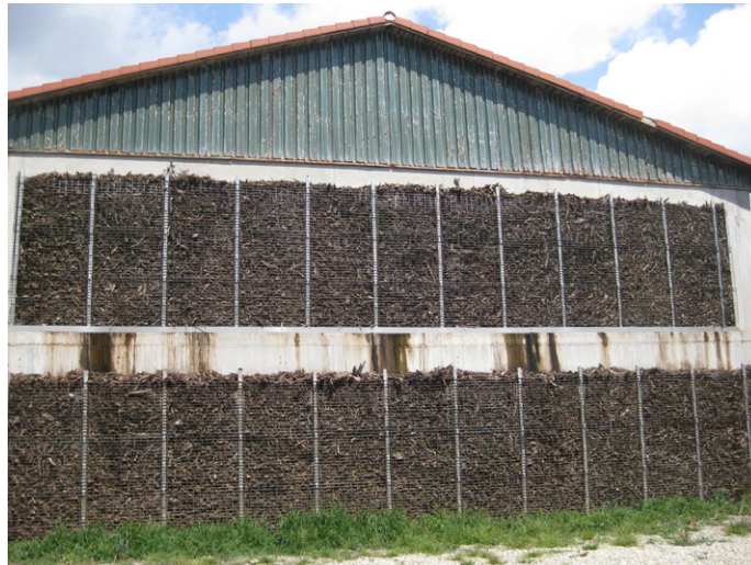
Abb. 21: Doppelstöckige Abgasreinigungsanlage
