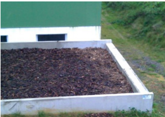
Abb. 79: Randgängigkeit durch trockene Stellen (Normalbild)
