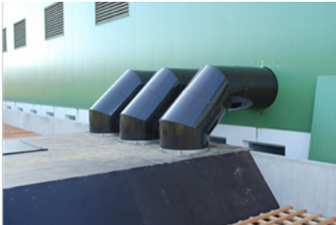
Abb. 76: Unbefüllter Biofilter mit drei Zuluftkanälen im vertikalen Druckkammerbereich
