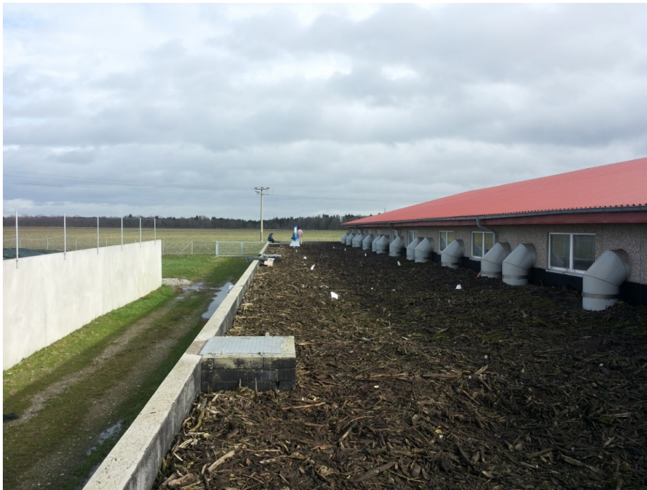
Abb. 81: Biofilter B eines Ferkel- aufzuchtstalles (4.080 Ferkelplätze)
