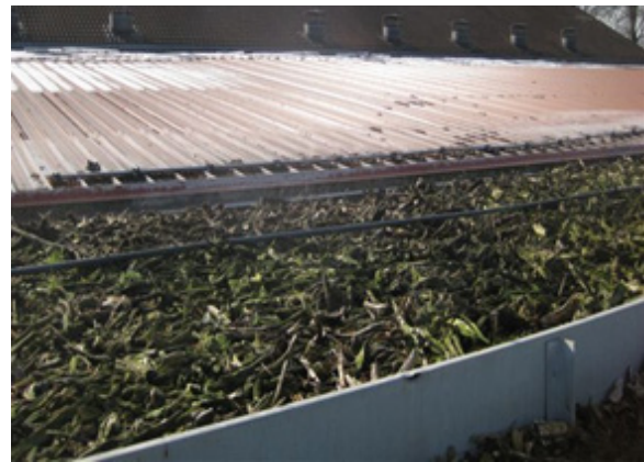
Abb. 16: Zweistufige AGR mit Biofilter und vorgeschalteter Wasserfilterwänden
