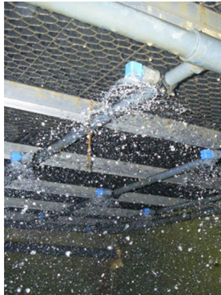
Abb. 37: Bedüsung und Tropfenabscheider nach der Optimierung
