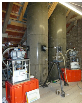
Abb. 41: Reingasmessplatz auf dem Dachboden
