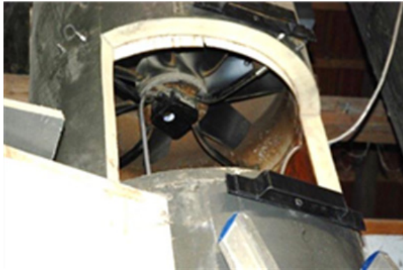
Abb. 38: Neuer Abgasventilator im Kamin
