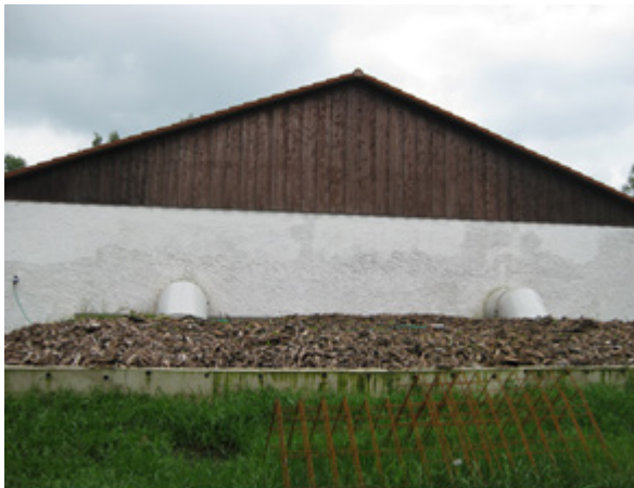
Abb. 7: Biofiltersystem aus den 80er Jahren für Mast-schweine (320 TP) mit Hackschnitzel
