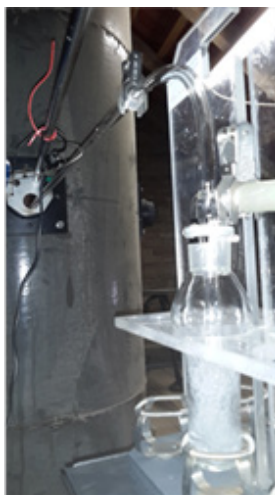
Abb. 27: Bioaerosol-Probenahme am Kamin 1 (Reingasmessplatz am Rieselbettreaktor)
