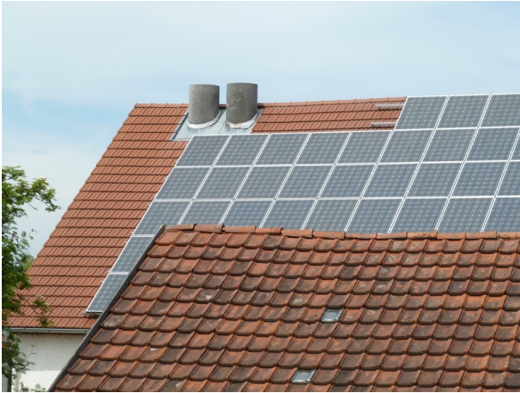
Abb. 30: Abluftkamine des Rieselbettreaktors (Nordansicht Stallgebäude)
