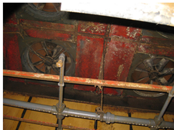
Abb. 12: Sprühdüsen eines alten Wasserwäschers ohne Tropfenabscheider für circa 350 Mastplätze
