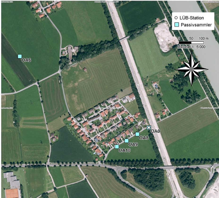
Abb. 5: Luftbild zur Lage der Messpunkte OA6 (loka- ler Hintergrund), OA0, OA8, OA9 und OA10 an der Autobahn A93 in Oberaudorf
