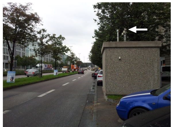
Abb. 58: Messpunkt an der LÜB-Station (seit 26.09.2013); ehemaliger Standort des Messpunkts MÜLA MP West
