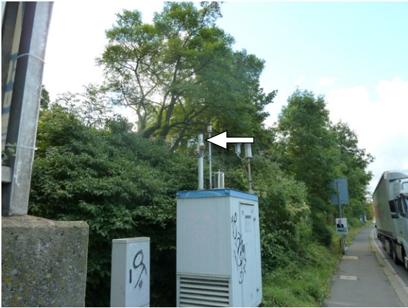
Abb. 5: Messpunkt WS0 Blickrichtung Südwesten
