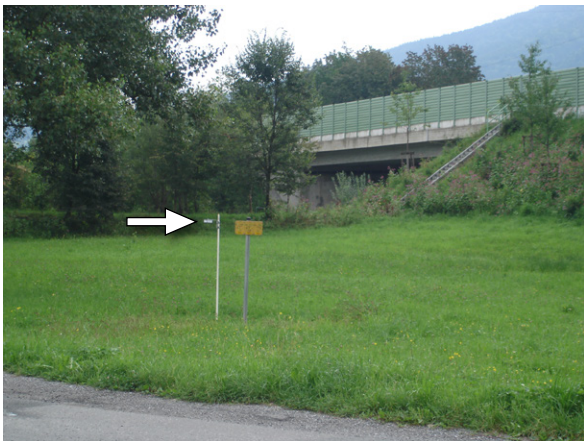
Abb. 25: Messpunkt OA11, Kiefersfelden (Marmorwerkstraße)
