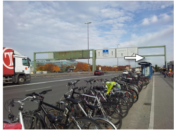
Abb. 72: Messpunkt Donnersbergerbrücke Ostseite (ML24) Blickrichtung Norden
