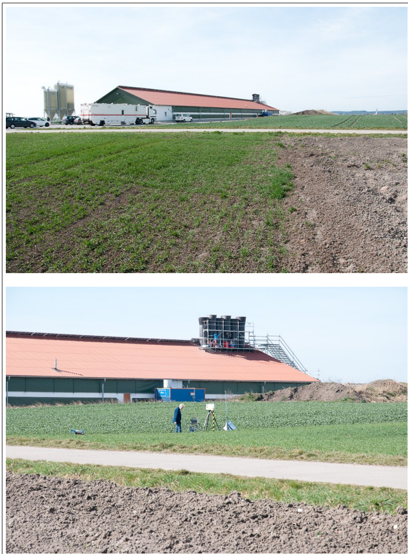
BILD 2: Oben: Anlage von Osten aus gesehen. Unten: Ansicht der 6 Abluftkamine (von links nach rechts: Kamin 1 bis Kamin 6). Im Vordergrund ist die Station I1/Im1 des Vormittags zu sehen (links der helle Kasten mit den Spülflaschen für die Bioaerosolmessung, rechts das Stativ mit dem SF 6 -Einlaßschlauch). Bilder UJ.
