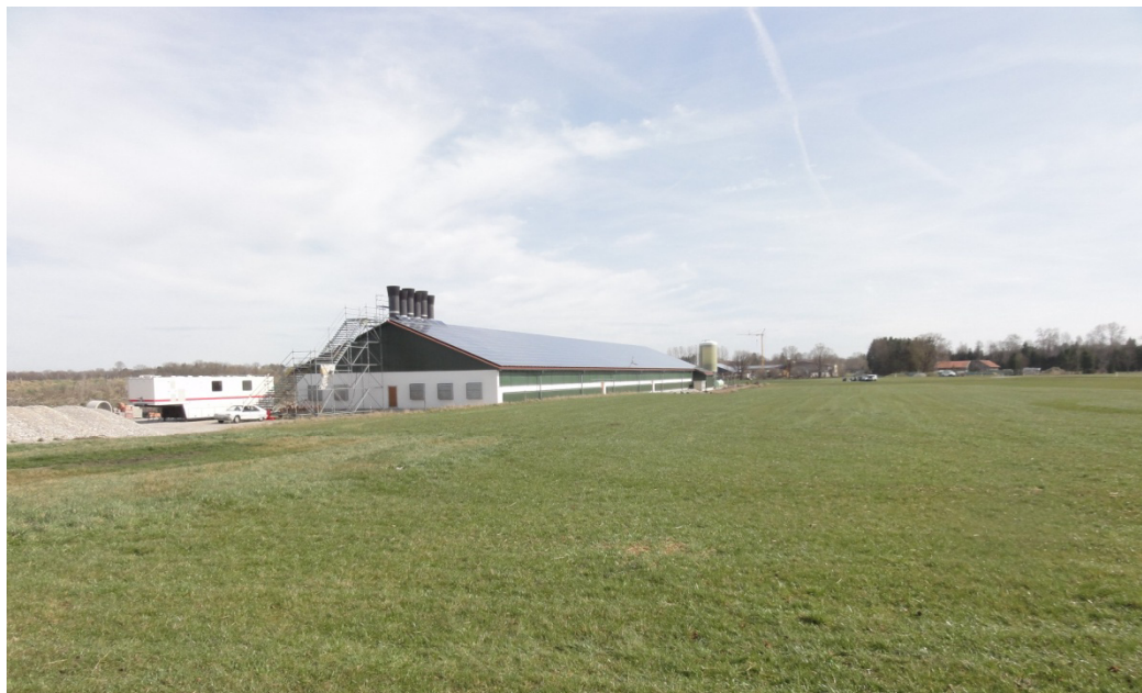
Abb. 4.3: Blick aus Südwest in Richtung Stall
