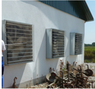
Abb. 12: Netzmessung mit einem Flügelradanemometer
