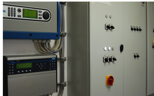
Abb. 15: Display Klimacomputer und Schaltkasten
