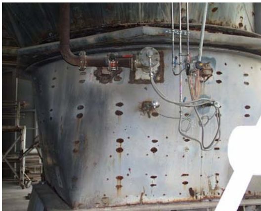
Abb. 6: Injektoren und Temperaturmessstellen auf der 27 m-Bühne
