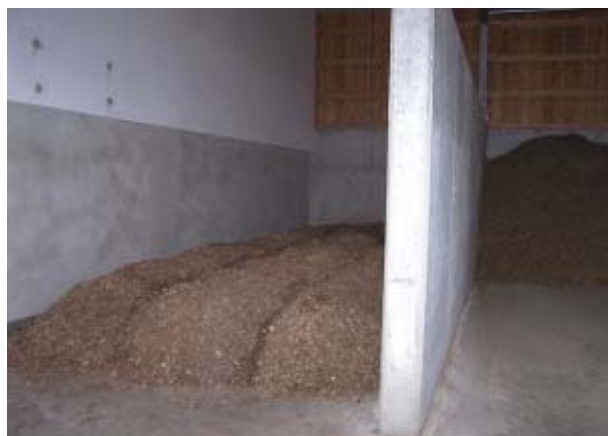
Abbildung 10-5 Flachlager zur Holzhackschnitzeltrocknung
