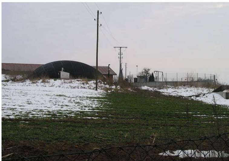
Abb. 6: Anlage VI mit Fermenter, Gashaube, Gärrückstandslager und Stallungen
