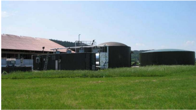
Abb. 7: Anlage VII mit Vorgrube, Maschinenraum, Fermentern und Nachgärbehälter
