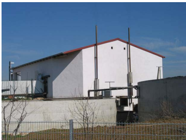
Abb. 8: Anlage VIII mit Maschinenraum, Notkühleinrichtungen und Gärrückstandslagern
