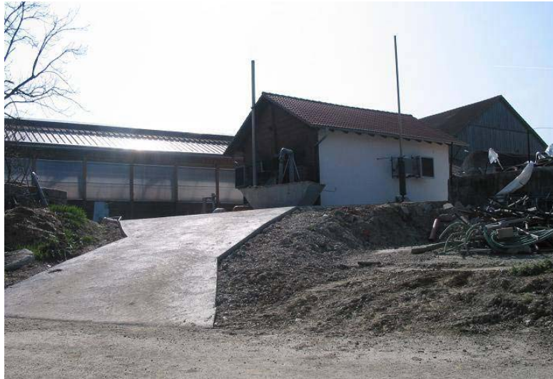
Abb. 3: Anlage III mit Maschinenraum, Fermenter Einspülschacht und Stallungen
