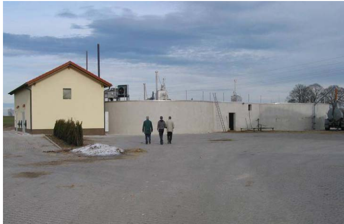
Abb. 5: Anlage V mit Maschinenraum, Fermentern und Notkühleinrichtung
