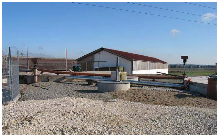
Abb. 2: Anlage II mit Fermenter, Pumpstation und Gärückstandslager
