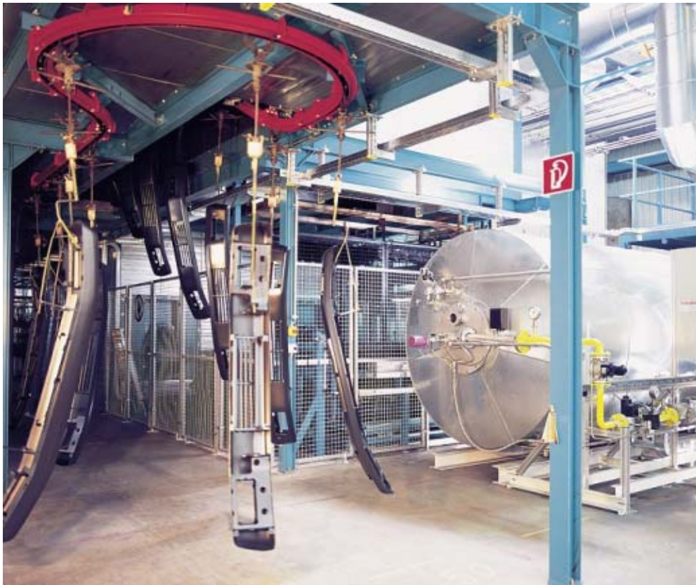
Abb. 4: KTL für Automobilzubehör (im Foto Stahl-Stoßfänger für Geländefahrzeuge) mit Abluftentsorgung über TNV, Nennleistung 3.500 Nm 3 /h, und Wärmerückgewinnung zur Heißwasserbereitung für die Vorbehandlungsanlage („Fotos EISENMANN“)
