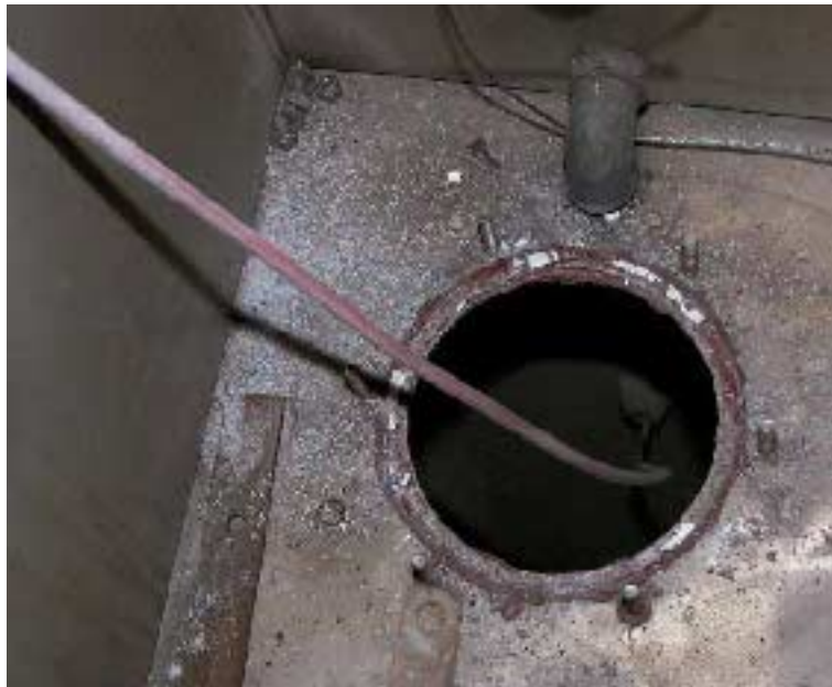
Bild 7.2-1: Demontage eines Filterelementes; durchgeführter Spannungsanschluss für das Heizelement
