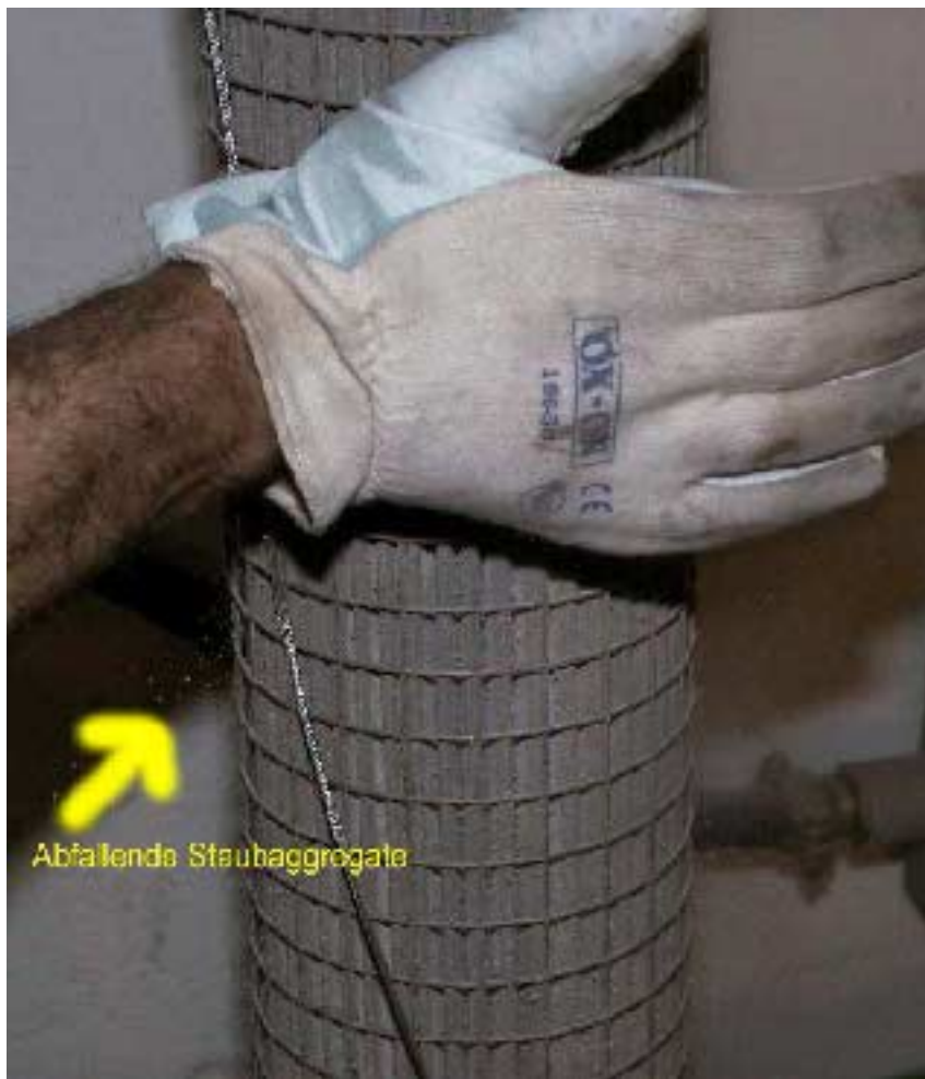
Bild 7.2-4: Abklopfen der Filterelemente – Staub löst sich völlig
