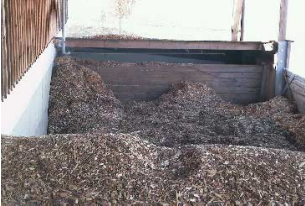
Bild 6.1-2: Brennstoff- Zwischenbunker
