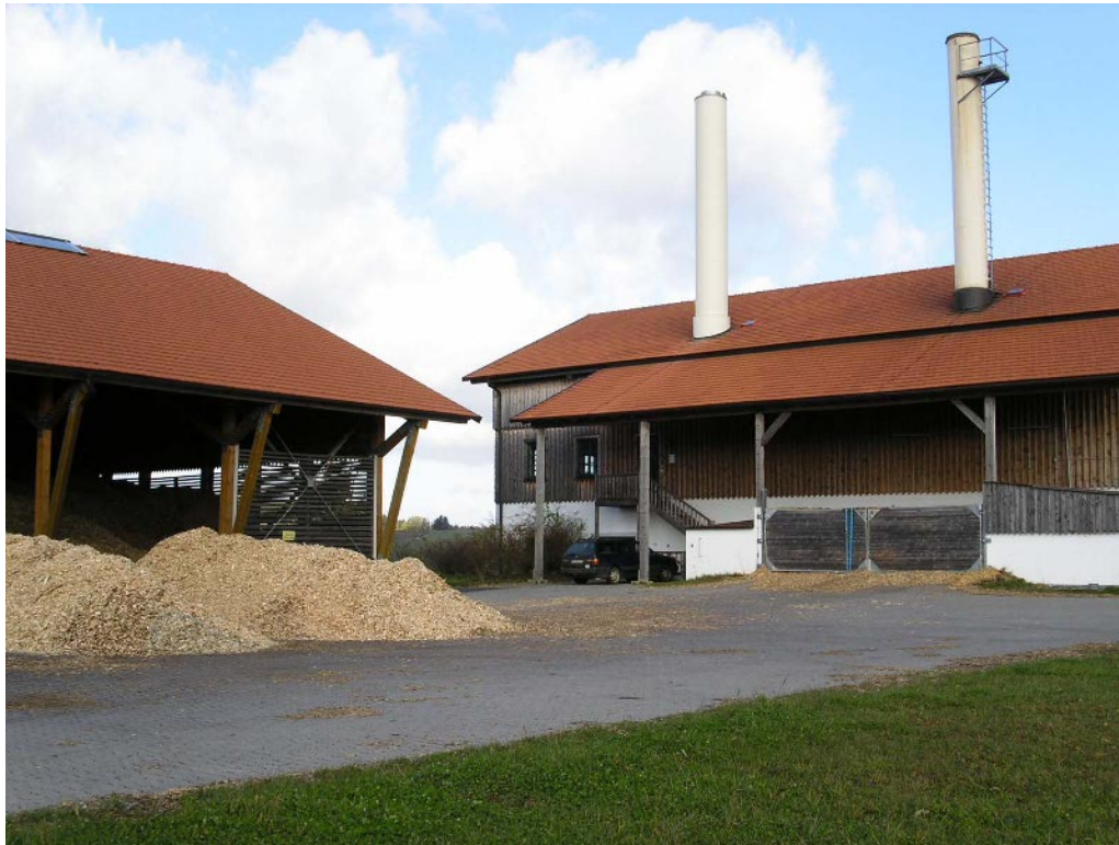
Bild 2.4-1: Heizhaus des Kurbetriebes Sibyllenbad
