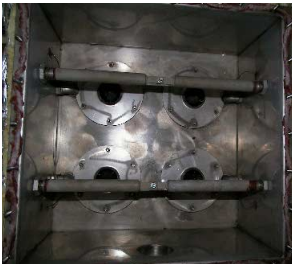
Bild 4.1-3: Reingasraum mit Düsenlanzen
