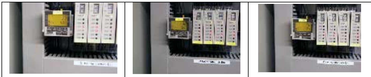
Bild 4.2-4: Reglerbaustein mit einzelnen Parametriereinstellungen für die Sollwerte von Heizstab( 21), Rohgasraum (31) und Reingas (41)
