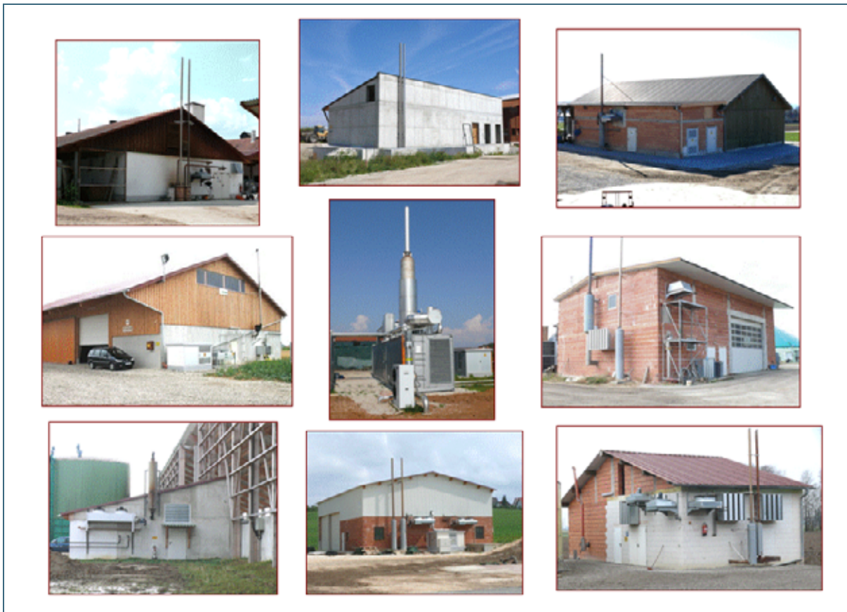
Abb. 4: Blockheizkraftwerks-Gebäude/Container von Biogasanlagen; Bereich Energieerzeugung
