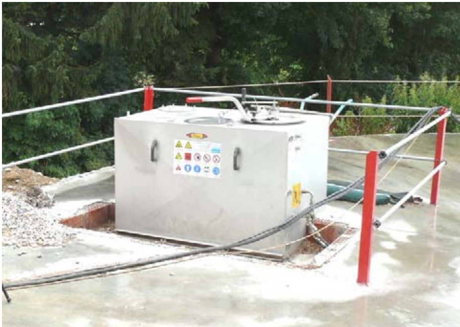
Abb. 27: Gekapseltes Fermen- ter-Rührwerk
