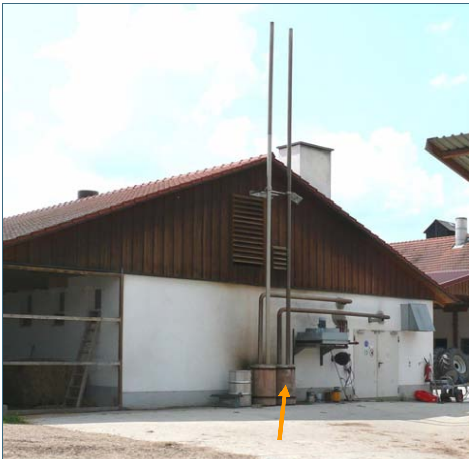
Abb. 29: Beispiel für ein BHKW- Gebäude einer Bio- gasanlage mit geringer Schallemission ( L_{WA} 85 dB(A)). Die Schall- dämpfergehäuse (Pfeil) sind gekapselt.
