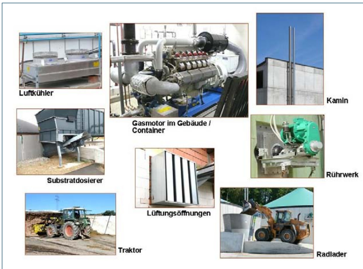
Abb. 6: Geräuschrelevante Komponenten einer Biogasanlage
