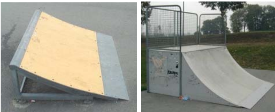
Bild 14 Jump Ramp mit Kunststoffbelag auf Metall-Unterkonstruktion (S27) (rechts) und Coping Ramp mit Kunststoffbelag mit seitlicher Verkleidung (S07) (rechts)
