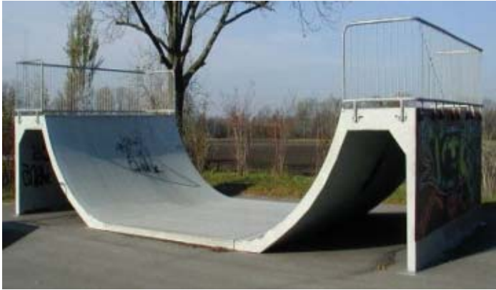
Bild 6 Minipipe aus Beton-Fertigteilen (S11)
