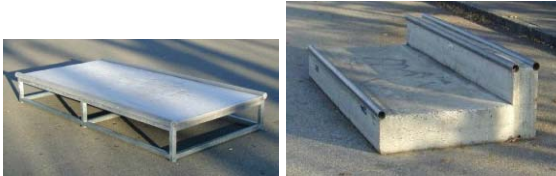
Bild 18 Olliebox mit Kunststoffbelag auf Metall-Unterkonstruktion (S23) (links) und Olliebox aus Beton (S17) (rechts)
