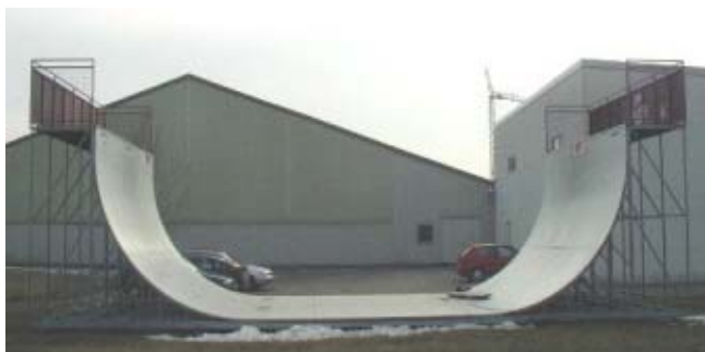
Bild 4 Halfpipe mit Kunststoff-Belag auf Metall-Unterkonstruktion (S31)
