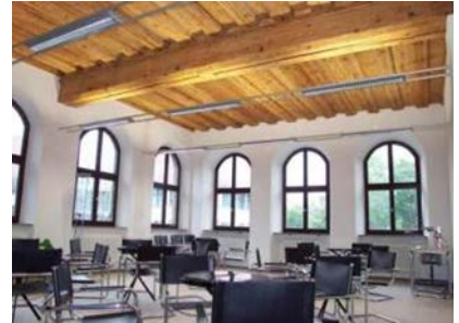
Abb. 7: Raum nach Sanierung
