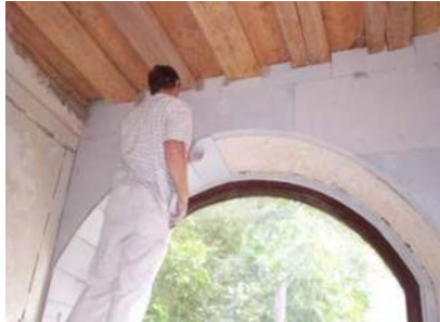
Abb. 6: Einbau Innendämmung
