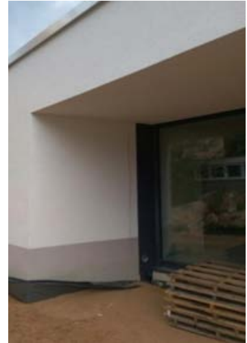
Abb. 19: Viatisschule – Außenansicht Dachüberstand
