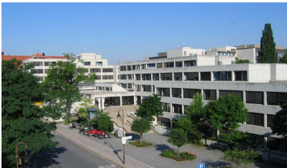
Abb. 1: Technisches Ämter- gebäude vor der Sanierung
