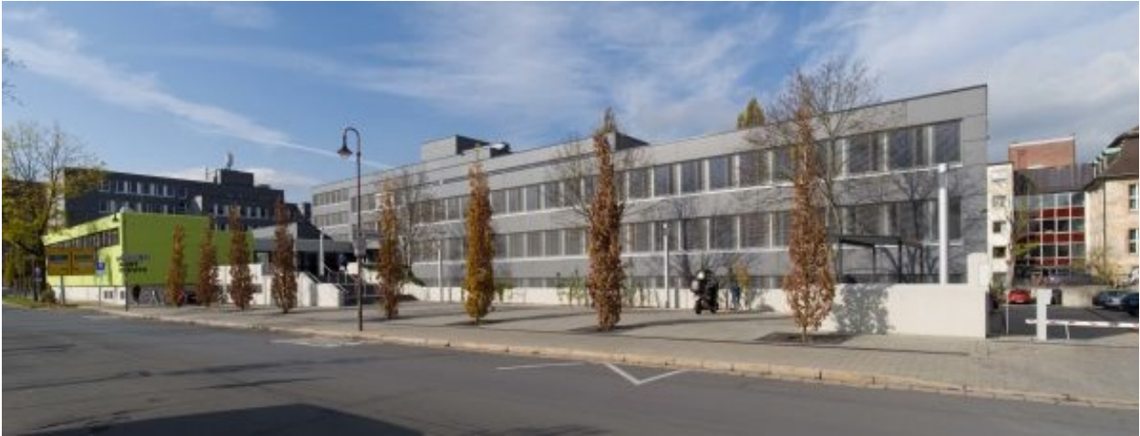
Abb. 4: Technisches Ämtergebäude nach der Sanierung
