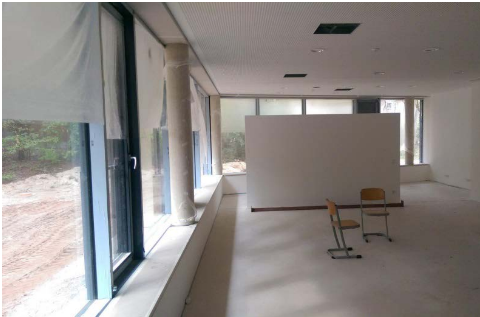
Abb. 17: Neubau Viatisschule - Brüstungen zur Last- verteilung
