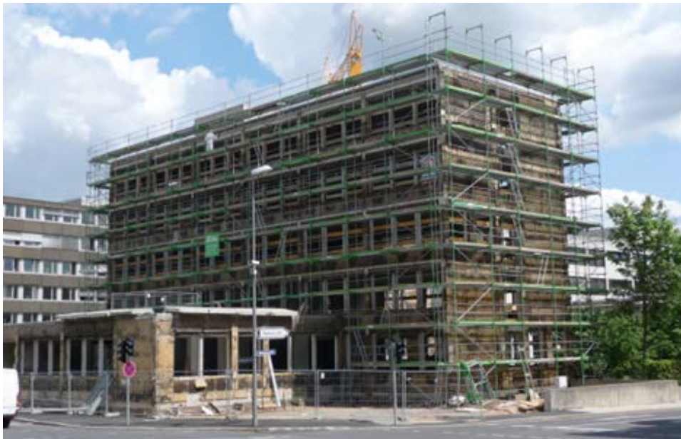
Abb. 2: Rohbauniveau erster Bauabschnitt
