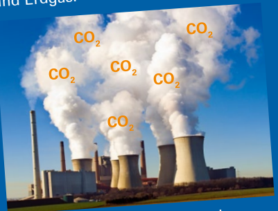
Kohlekraftwerk in Deutschland
