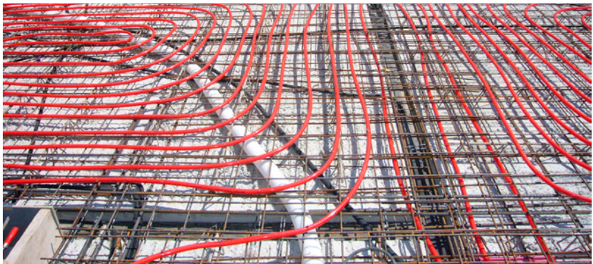
Abbildung 12: Verlegung der Betonkernaktivierung in einer Betondecke
