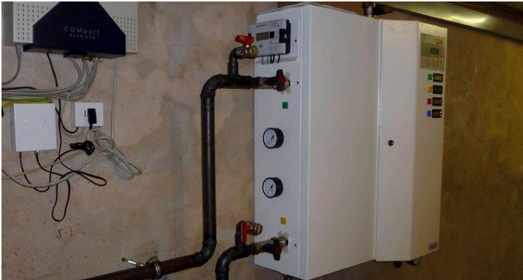
Eine typische Übergabestation für ein Ein- bis Zweifamilienhaus hat eine Größe von ca. 80 x 60 x 40 cm und eine Lebensdauer von etwa 30 Jahren.
