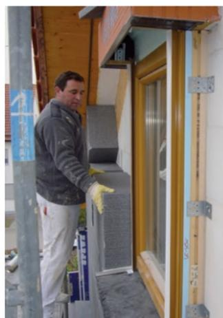
*Dieses Fenster wurde mit Außenwinkeln angebracht.*
